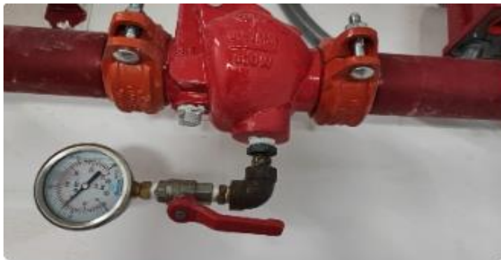
Lectura de manómetros y estaciones de control del cronograma febrero piso 9 / 95 psi
