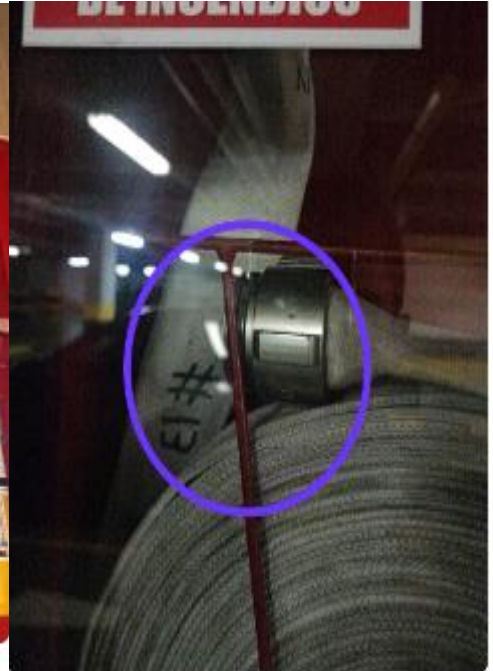
Elementos de gabinetes se reporta cambio de boquilla chorro niebla de 1 1/2" en bronce x 150 psi UL/FM gabinete #13
