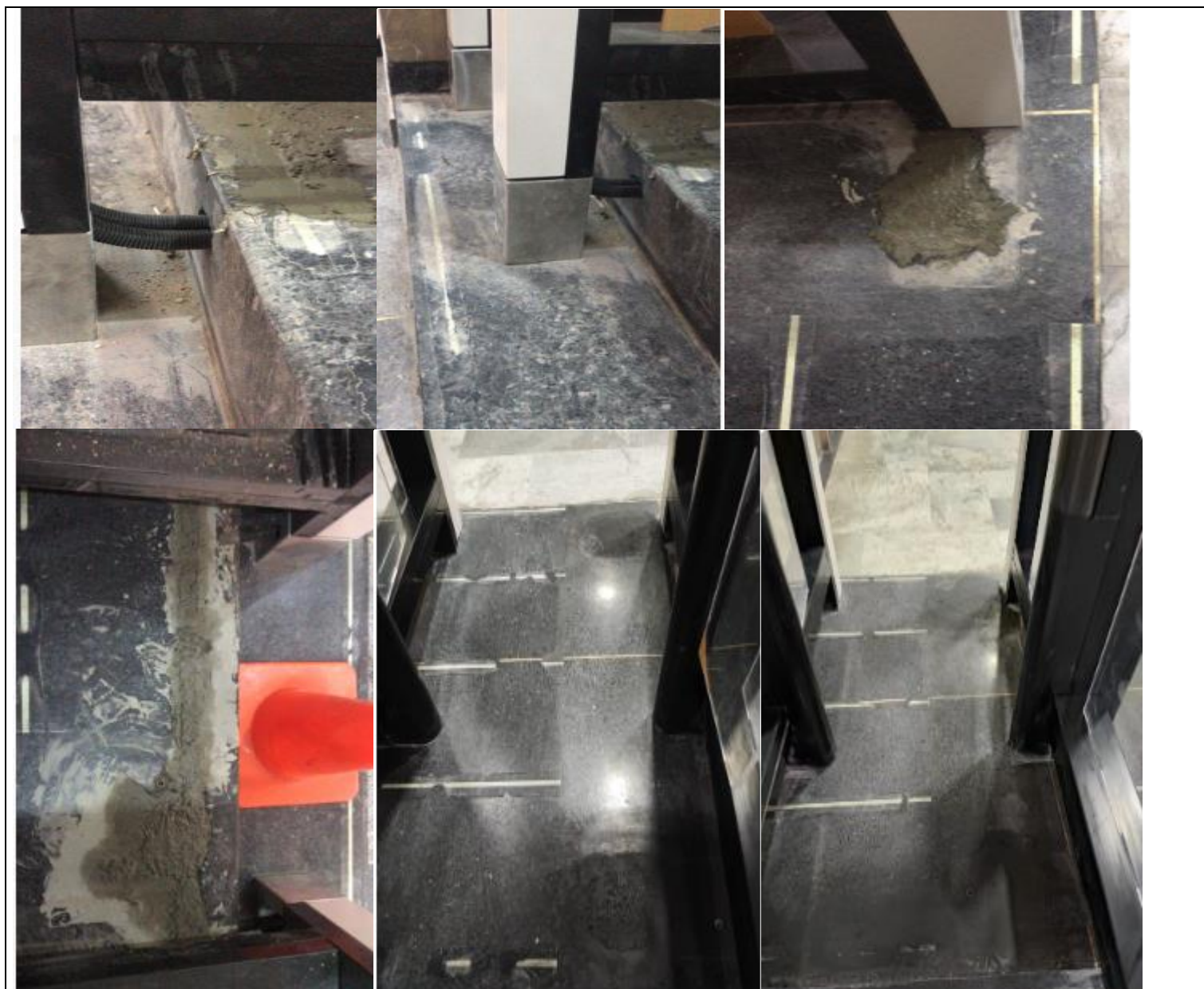
Se realiza el resane de piso en granito
