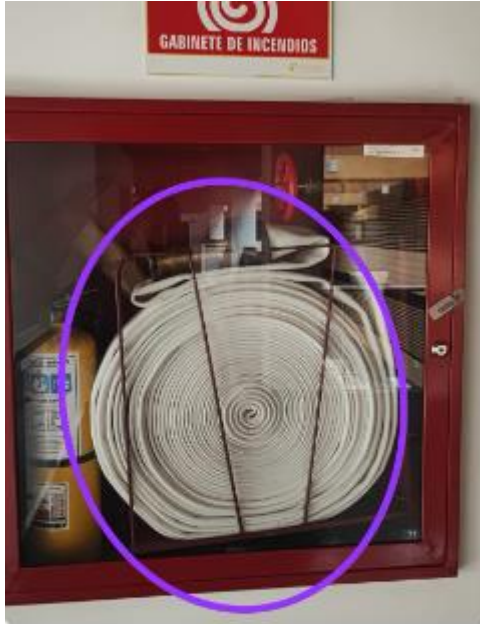
Revisión de elementos gabinetes casas de santa bárbara manguera para cambio de 2 1/2" chaqueta sencilla x 150 psi x 30 metros largo reporte en pruebas mes de diciembre
