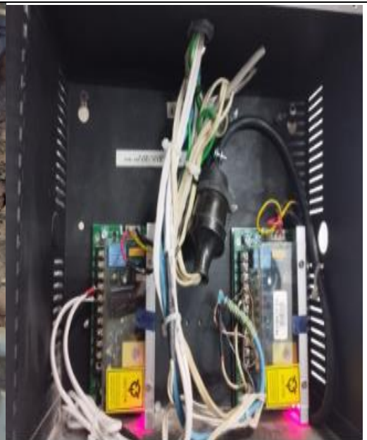
P10 cuarto de ascensores fuentes control de acceso piso 10 cuarto de ascensores y piso 8
