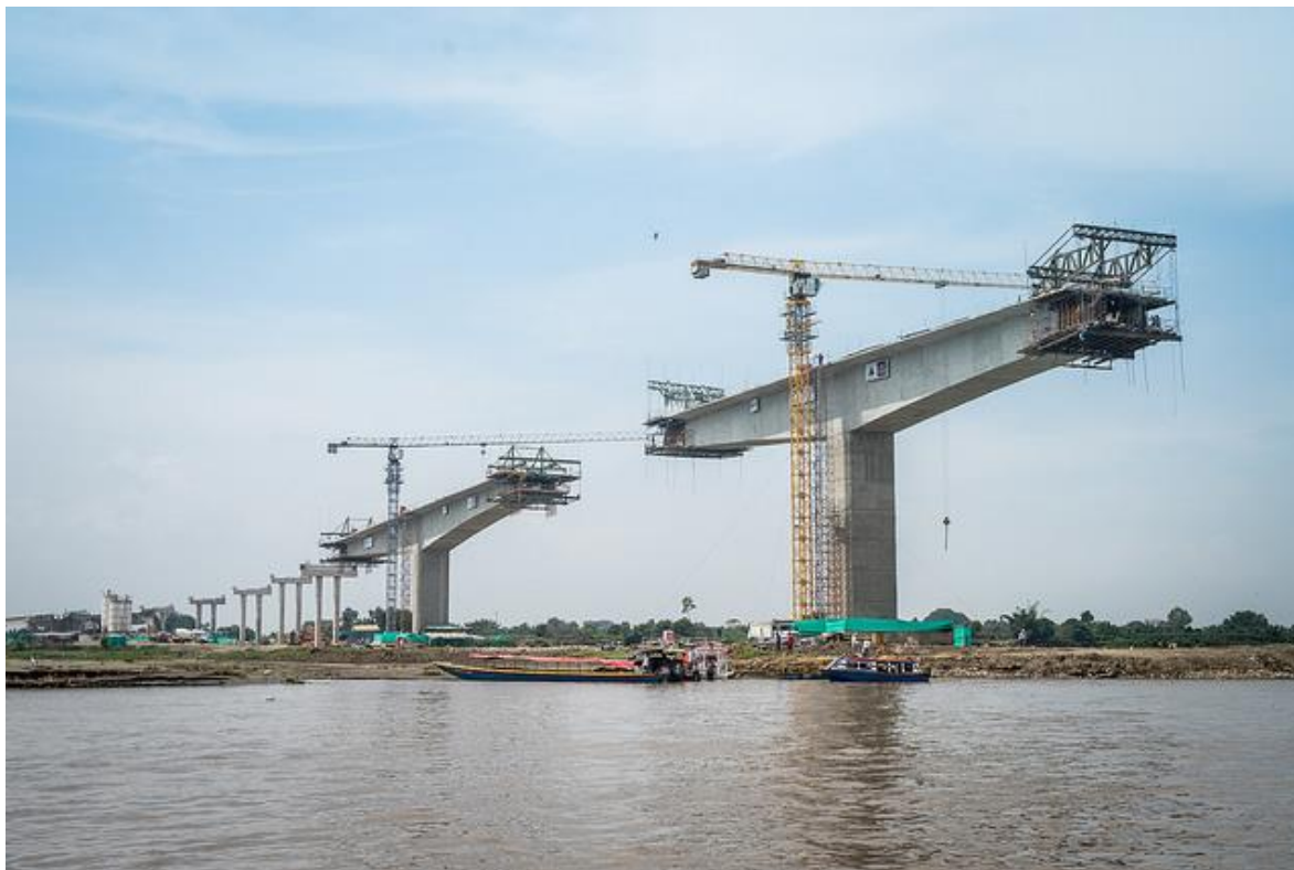
Puente Yatí – Bodega
