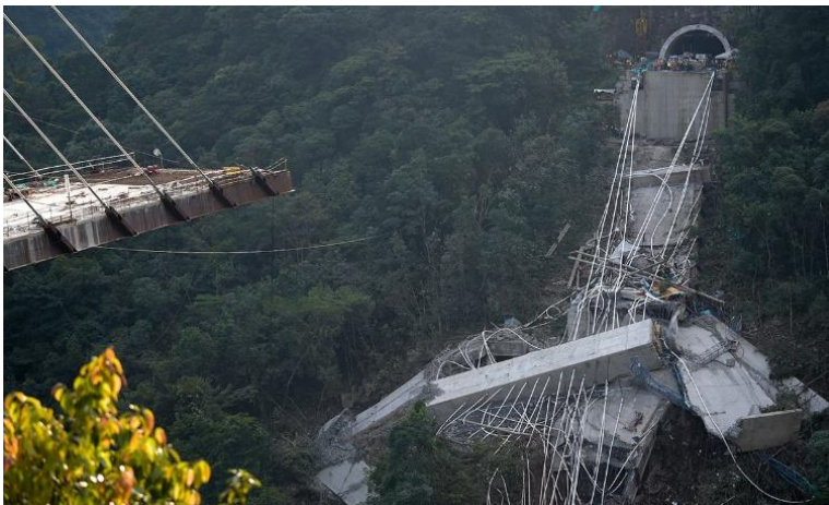
Imagen N° 1: Derrumbe del Puente Chirajara 281 .
