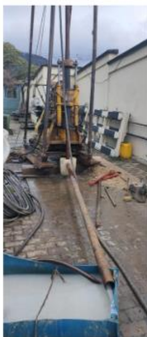
Fotografía 4-1 Ejecución de perforaciones
