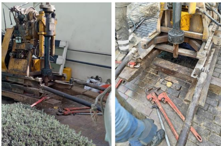
Figura 1. Instalación tubo inclinómetro en terreno
