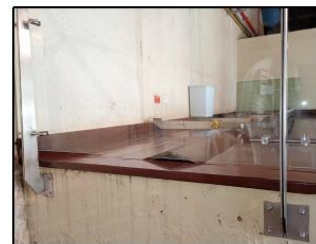
Fotografía 6. Lesiones por ondulaciones y grietas en la tarima.
