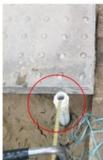
Figura 6. Piezómetro tipo Casagrande instalado – Casas de Santa Barbara de Minihacienda
