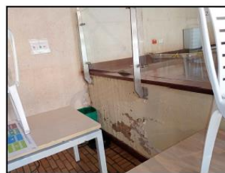
Fotografía 6. Lesiones por ondulaciones y grietas en la tarima.
