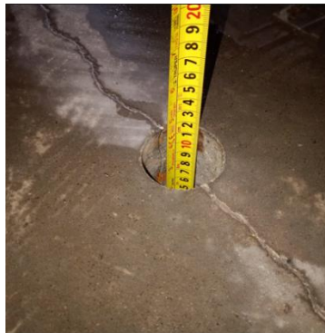
Fotografía 2. Acero mal colocado o insuficiente en la placa.
