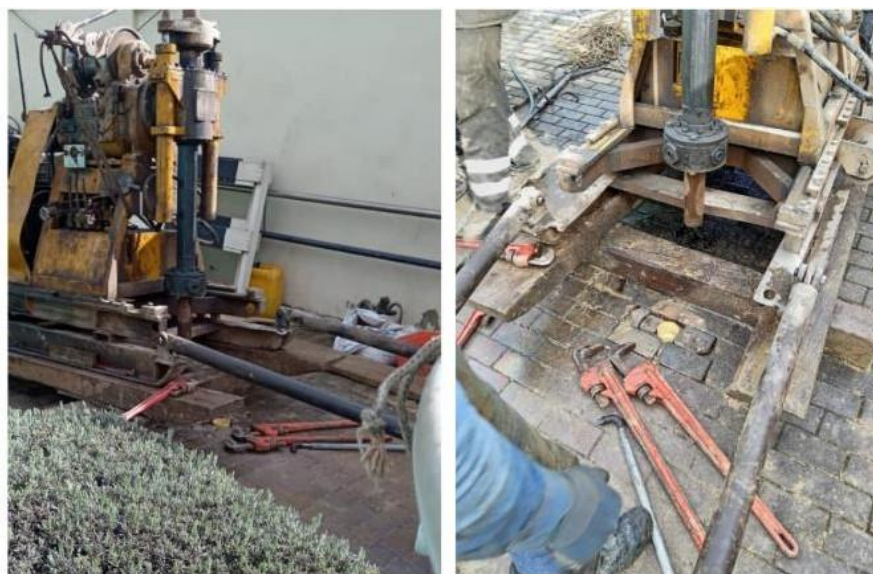
Figura 1. Instalación tubo inclinómetro en terreno
