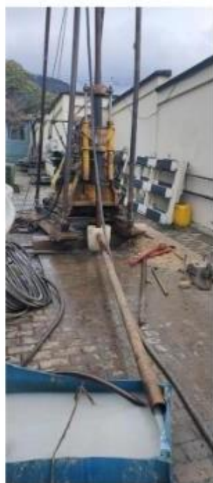
Fotografía 4-1 Ejecución de perforaciones
