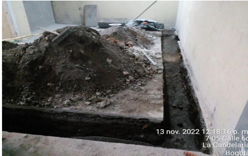
Descripción: Se informa de la limpieza, trazo, nivelación, excavación de cárcamo en sótano que se ubica en cuarto nuevo de subestación
