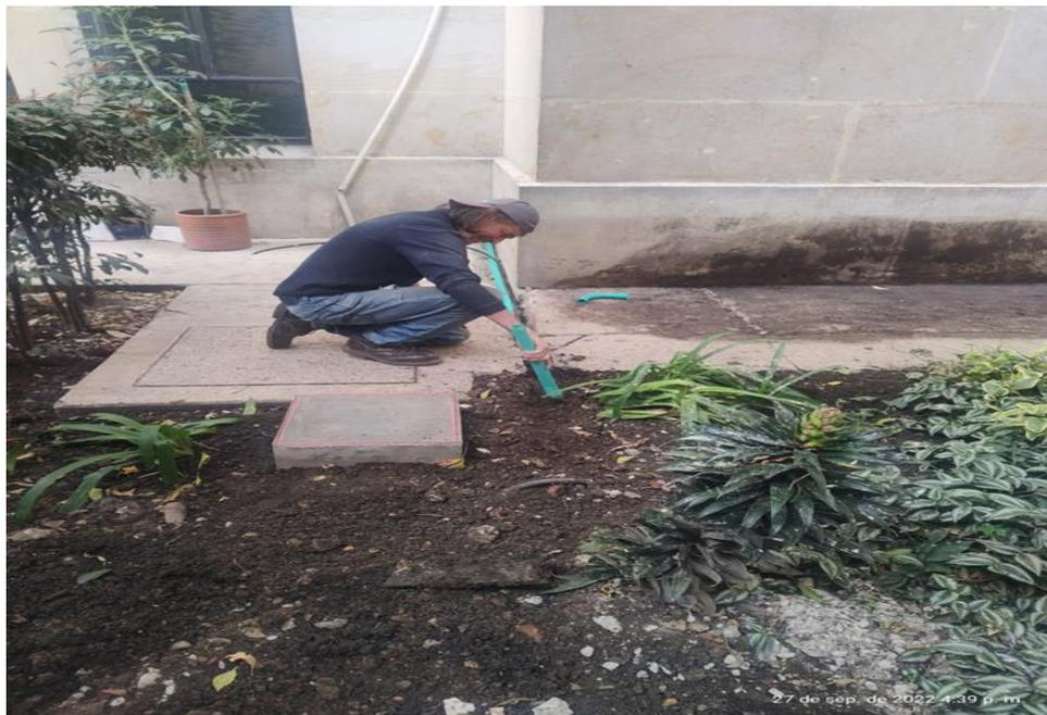
Instalación tubería bajantes a caja de inspección.
