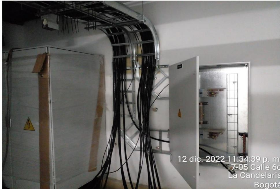
Descripción: Suministro e instalación de tablero de distribución del sistema de aire acondicionado.
