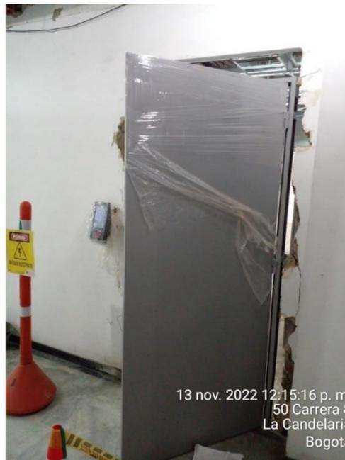
Descripción: Instalación de puerta Corta fuego, en cuarto técnico de ups de 100 Kva y de 200 Kva, adjunto a cafetería de sótano
