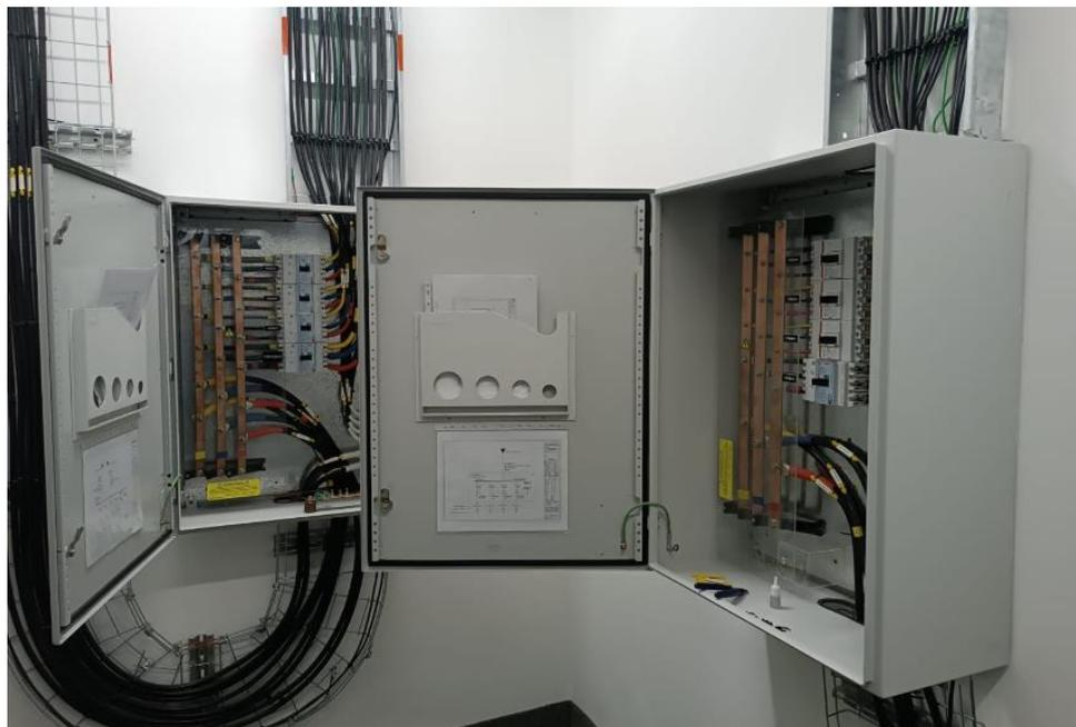
Descripción: Estado tablero con marquillas, diagrama unifilar y manual usuario.
