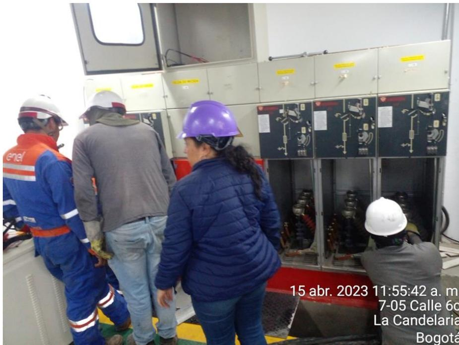
Descripción: Personal operativo ENEL-Codensa, desconexión alimentador existente de celdas antiguas.
