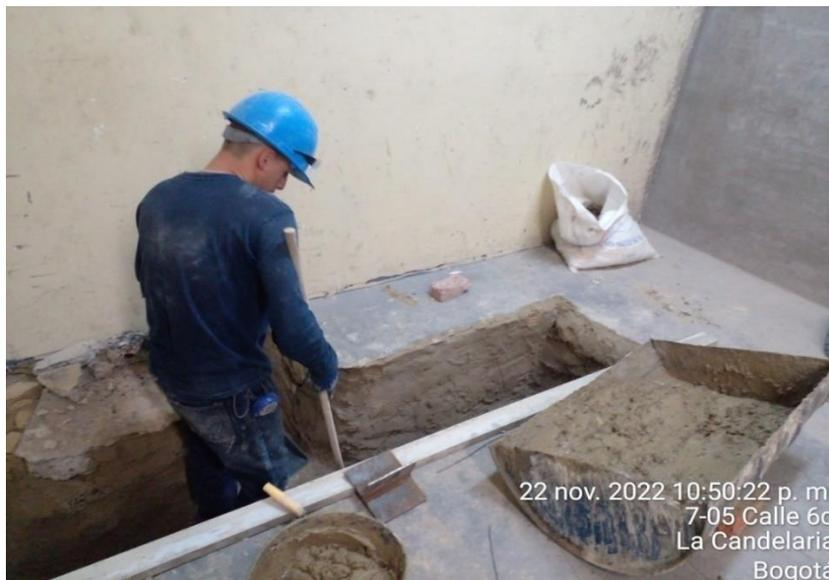
Descripción: Se informa de la limpieza, trazo, nivelación, excavación de cárcamo en sótano que se ubica en cuarto nuevo de subestación
