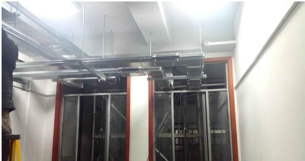
Descripción: Se informa Suministro e instalación de codo vertical electrobarra 800A - AL-3F+N120+T+FE - Aluminio - IP55 - Temp.Ref 40°C - Libre de halógenos - Auto-extinguible - aislamiento 130°C - (Incluye elementos de fijación, bloques y accesorios de instalación)
