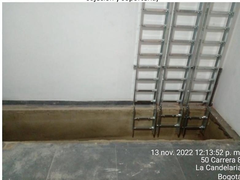
Descripción: Instalación de bandeja tipo ducto de 30x8 cm - Calibre 18 - Pintura electrostática color blanco (sistema normal / sistema regulado) para distribución horizontal (Incluye elementos de sujeción y soportería)
