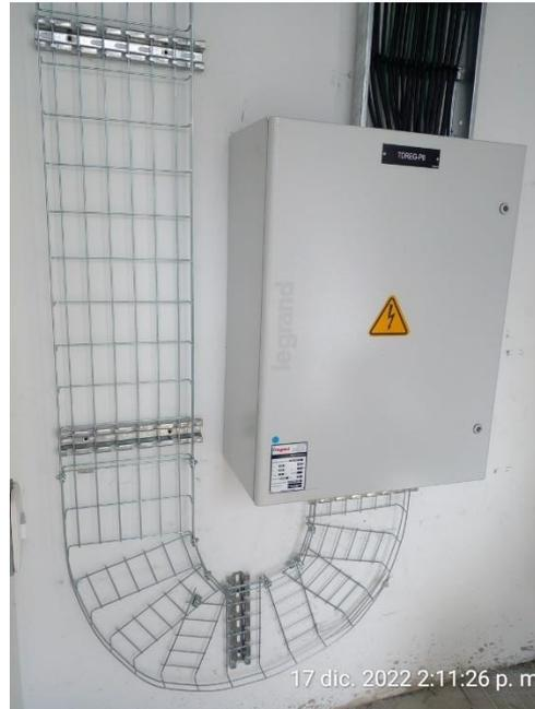
Descripción: Se informa instalación de bandeja porta cable tipo malla cablofil en piso octavo.
