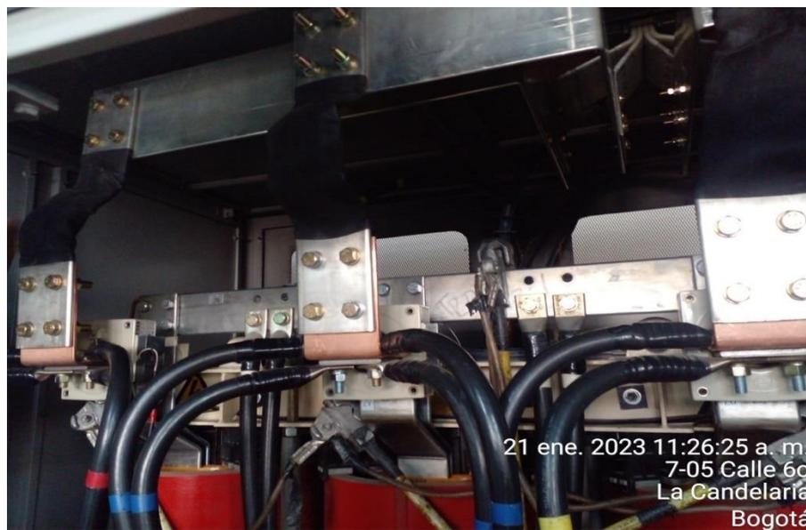
Descripción: Barraje cobre y conexión alimentador, desde fases de transformador.
