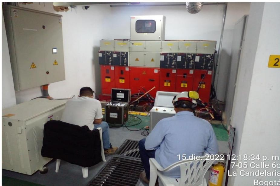
Descripción: Se informa de las pruebas del cable en media tensión (Pruebas VLF, "Very Low Frequency").
