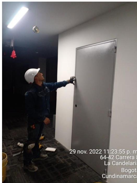
Descripción: Instalación de puerta Corta fuego, en cuarto técnico del séptimo piso, adjunto a la entrada de zona norte.
