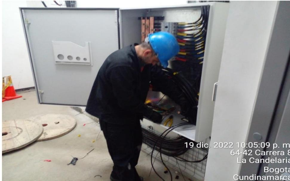
Descripción: Se informa instalación, conexiones en tableros mediante el sistema de peine, para la parte de potencia, siempre y cuando los conductores y aislamientos cumplan con los requisitos establecidos.
