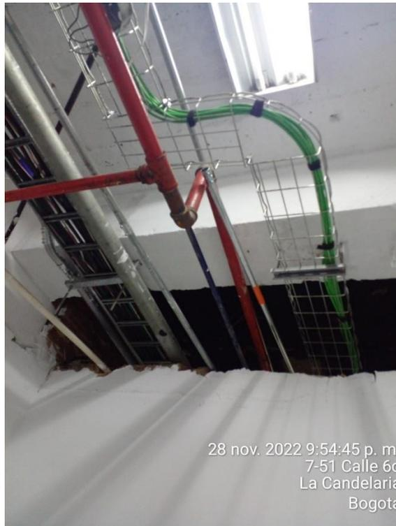
Descripción: Instalación de tubería EMT de 3/4" zona pasillo, cuya función es para alojar circuito de iluminación.
