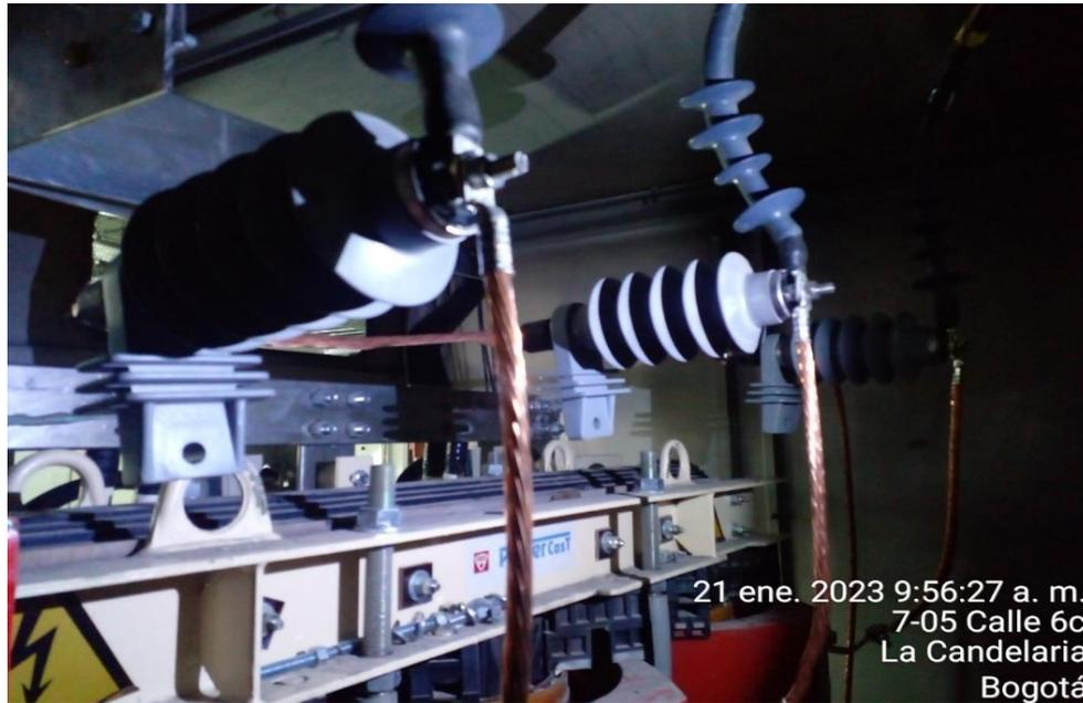
Descripción: DPS de transformador con soporte permanente.
