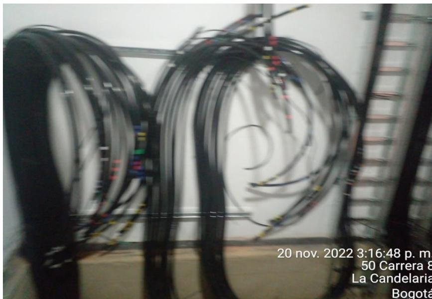
Descripción: Instalación de acometida en cable de cobre, adjunto en cuarto técnico de ups de 100 Kva y de 200 Kva, adjunto a cafetería de sótano
