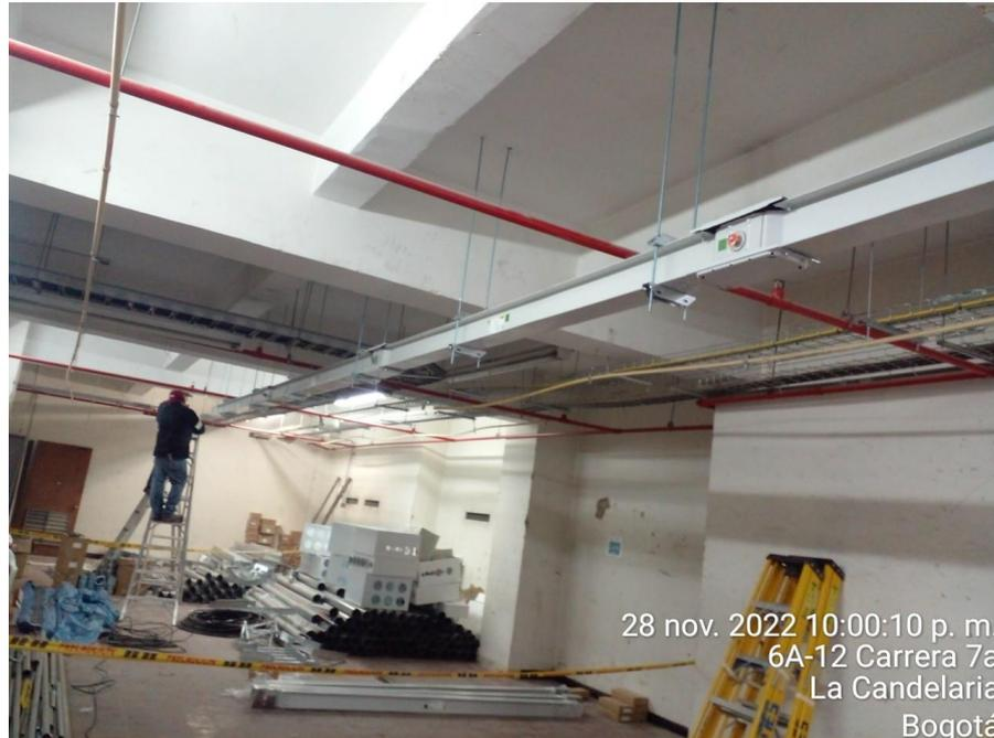
Descripción: Se informa instalación de electrobarra en el almacén provisional adjunto al cuarto técnico nuevo de la subestación.
