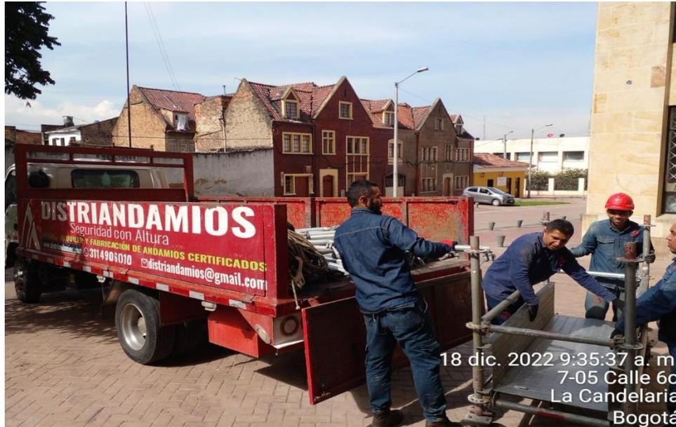
Descripción: Se informa ingreso de soportes, travesaños, plataforma, secciones de andamios para la instalación de electrobarras en fachada exterior de la zona central del edificio
