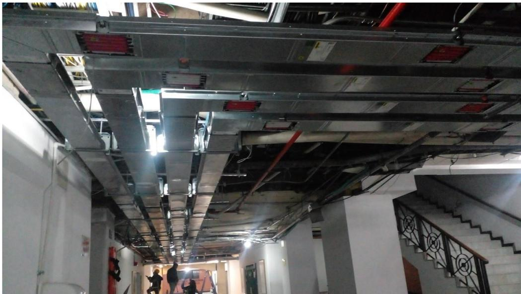
Descripción: Se informa Suministro e instalación de codo horizontal electrobarra 800A - AL-3F+N120+T+FE - Aluminio - IP55 - Temp.Ref 40°C - Libre de halógenos - Auto-extinguible - aislamiento 130°C - (Incluye elementos de fijación, bloques y accesorios de instalación)
