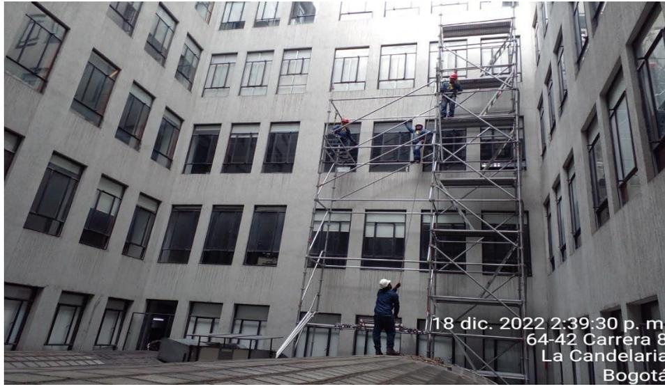
Descripción: Se informa armado de secciones de andamios para la instalación de electrobarras en fachada exterior de la zona central del edificio
