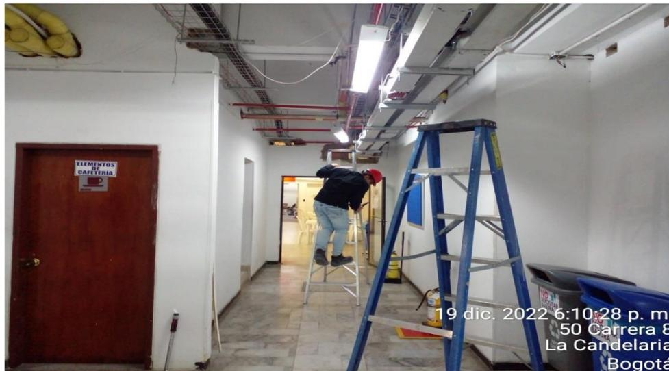
Descripción: Se informa Suministro e instalación de tramo alimentador sin derivaciones electrobarra 315A - AL- 3F+N+T+TE - Aluminio - IP55 - Temp.Ref 40°C - Libre de halógenos - Auto-extinguible - aislamiento 130°C - Tramo 3 m (Incluye elementos de fijación, bloques y accesorios de instalación)
