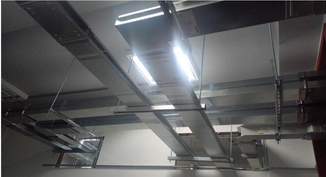
Descripción: Se informa Suministro e instalación de codo vertical electrobarra 315A - AL-3F+N120+T+FE - Aluminio - IP55 - Temp.Ref 40°C
