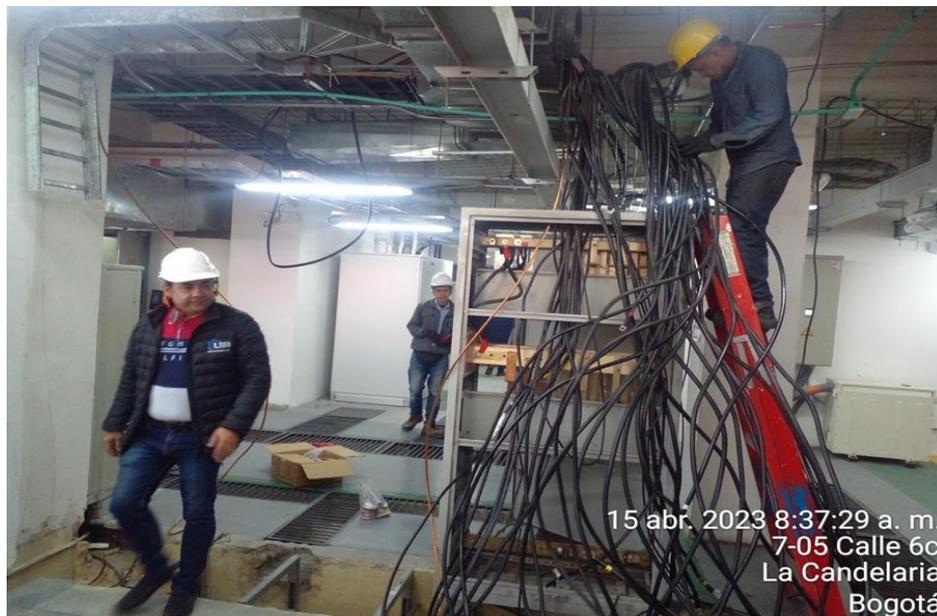
Descripción: Desconexión acometidas tablero TGA – 1 para traslado.
