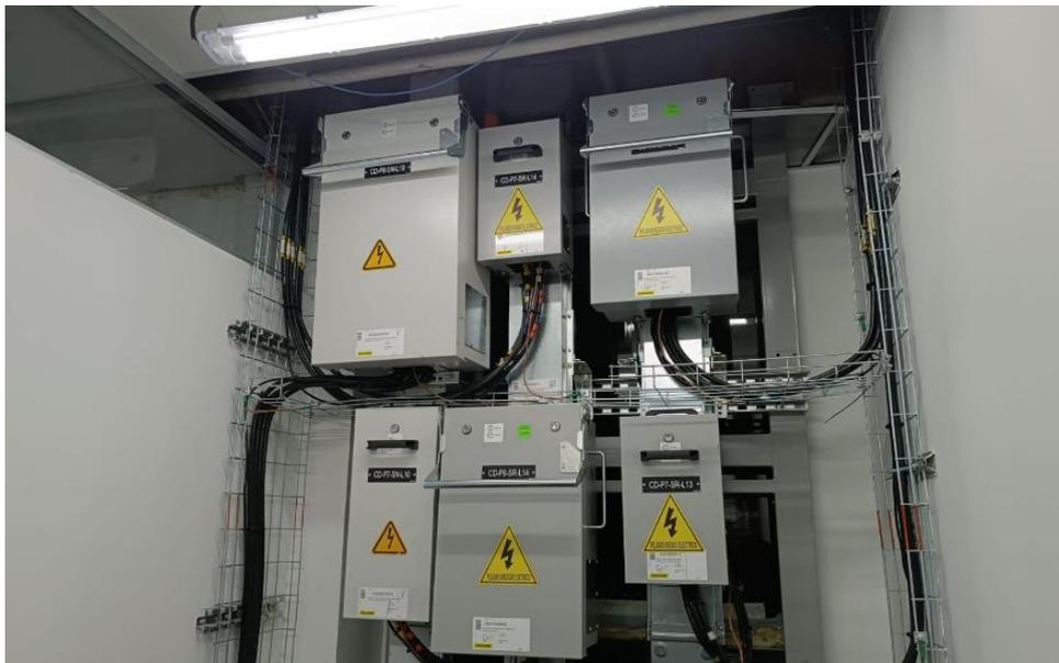
Descripción: Cajas derivación Electrobarras, cuarto eléctrico piso 8.
