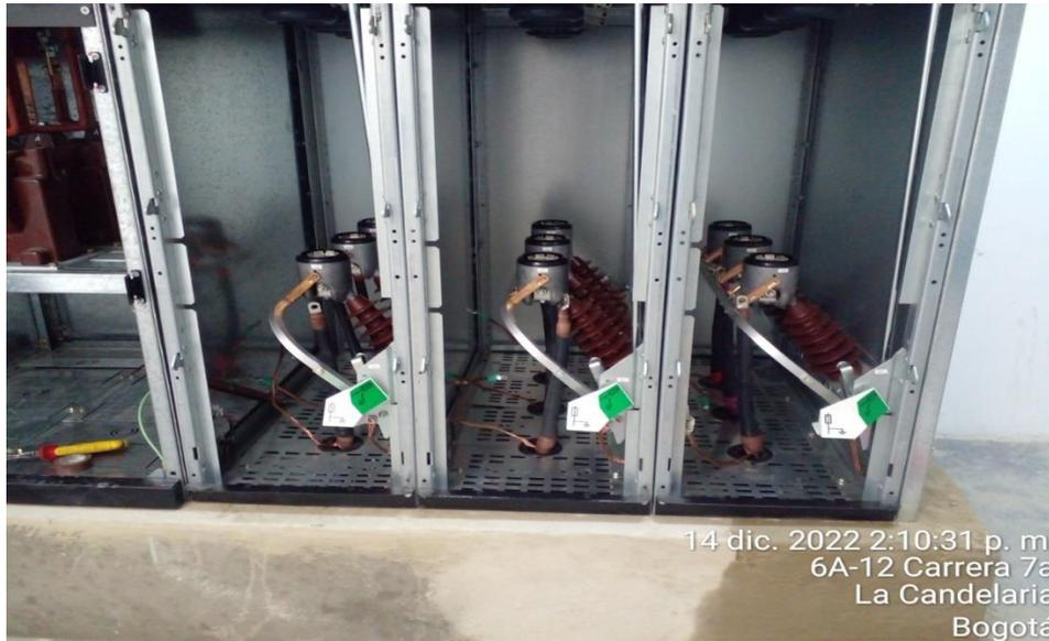
Descripción: Verificación fusibles y celdas media tensión (630A aislamiento SF6 - 15kV - Icc=25KA), protección transformadores 500 KVA.
