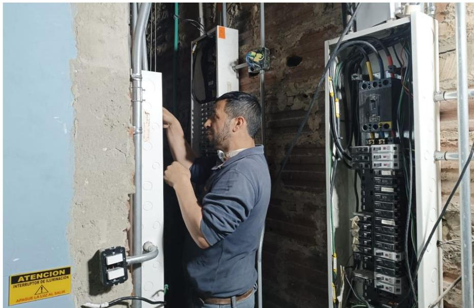
Descripción: Figurado y conexión tablero, vertical piso 7
