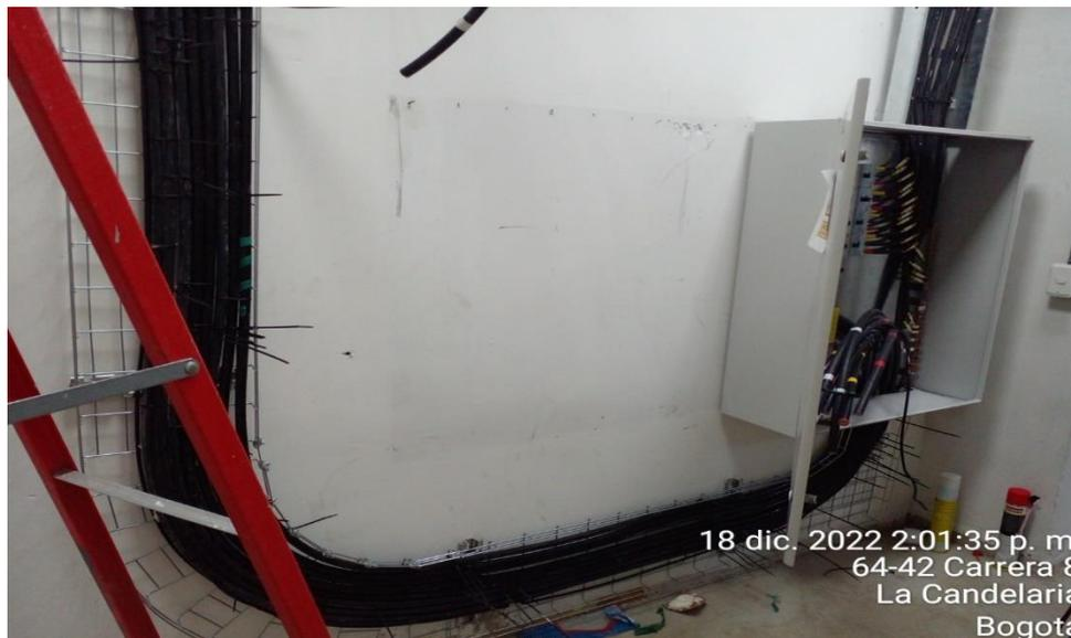
Descripción: Se informa instalación, conexiones en tableros mediante el sistema de peine, para la parte de potencia, siempre y cuando los conductores y aislamientos cumplan con los requisitos establecidos.
