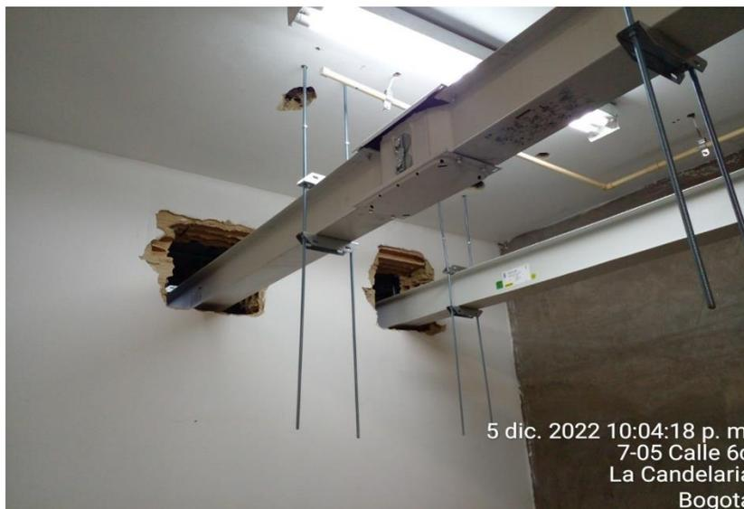
Descripción: Suministro e instalación de tramo alimentador sin derivaciones electrobarra 1600A - AL- 3F+N+T+TE - Aluminio - IP55 - Temp.Ref 40°C - Libre de halógenos - Auto-extinguible - aislamiento 130°C - Tramo 3 m (Incluye elementos de fijación, bloques y accesorios de instalación). En el cuarto técnico nuevo de la subestación.
