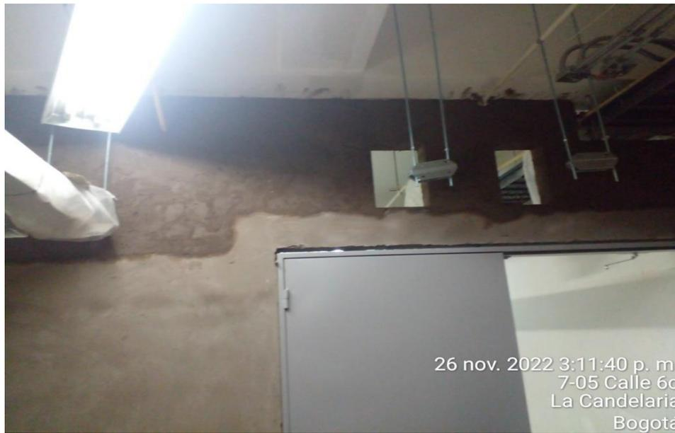
Descripción: Se informa instalación de elementos de sujeción y soportería para la electro barra
