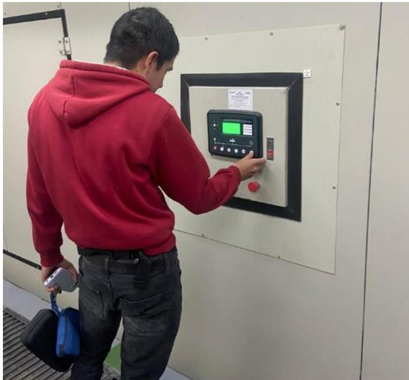
Descripción: Encendido planta, prueba en vacío.
