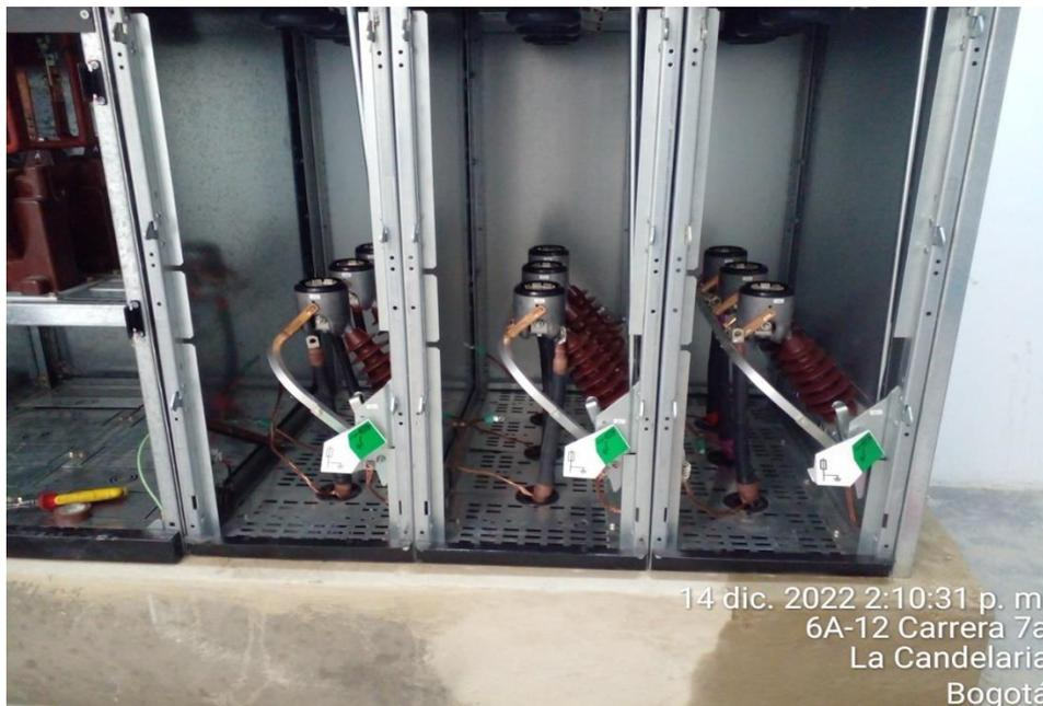
Descripción: Suministro e instalación de celda de entrada en media tensión 630A aislamiento SF6 - 15kV - Icc=25KA.
