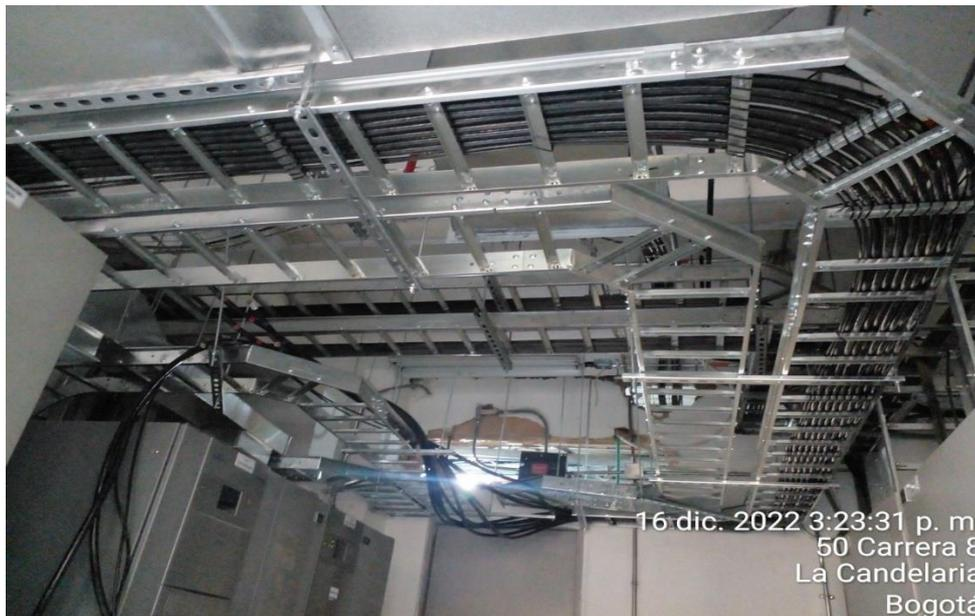
Descripción: Instalación de bandeja tipo ducto de 30x8 cm - Calibre 18, en cuarto de ups
