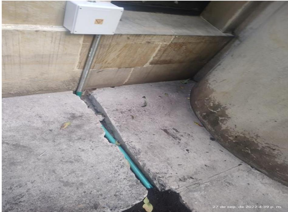
Instalación tubería bajantes a caja de inspección.
