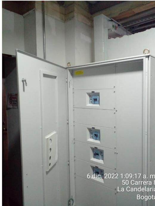
Descripción: Suministro e instalación de tablero de distribución, adjunto en cuarto técnico de ups de 100 Kva y de 200 Kva, adjunto a cafetería de sótano.
