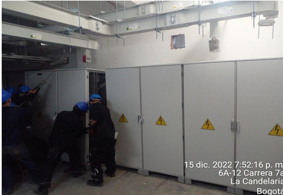
Descripción: Suministro e instalación de tablero general principal en cuarto técnico de subestación.
