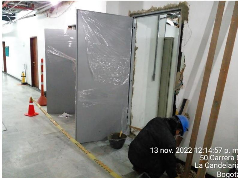
Descripción: Instalación de puerta Corta fuego, en cuarto técnico de ups de 100 Kva y de 200 Kva, adjunto a cafetería de sótano
