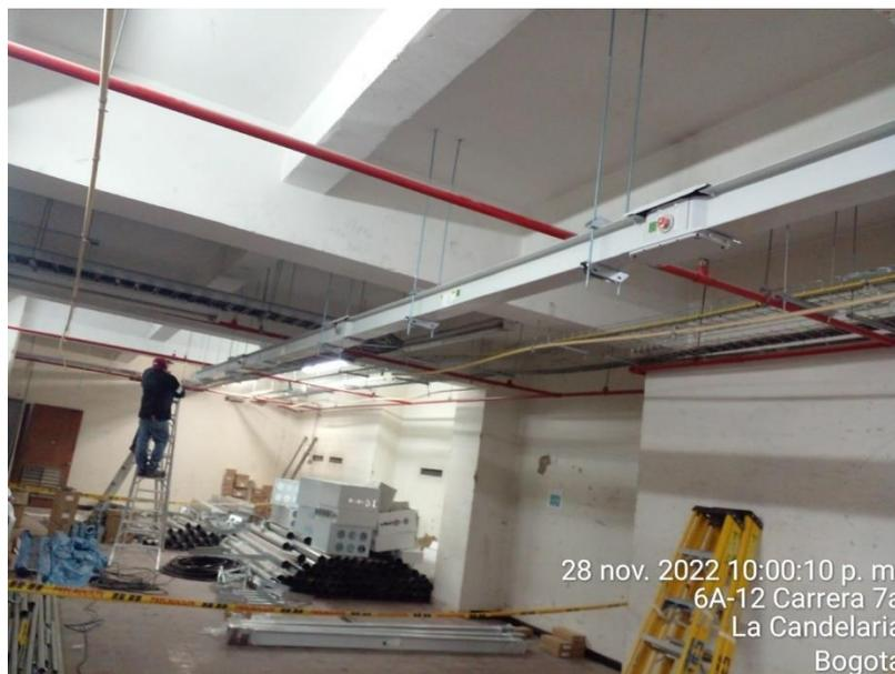
Descripción: Se informa instalación de electro barra en el cuarto técnico nuevo de la subestación y adjunto a la subestación.
