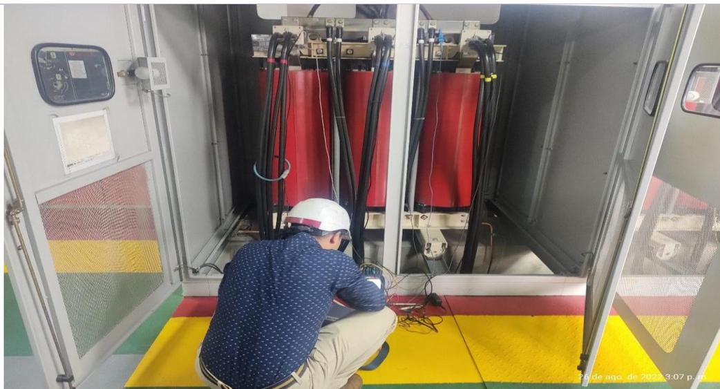
Descripción: Se realiza desconexión equipos analizadores de red pasadas 24 horas, validación cargas consumidas, por cada transformador de la subestación.
