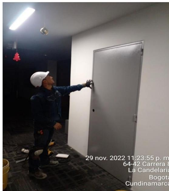
Descripción: Instalación de puerta Corta fuego, en cuarto técnico del séptimo piso, adjunto a la entrada de zona norte.
