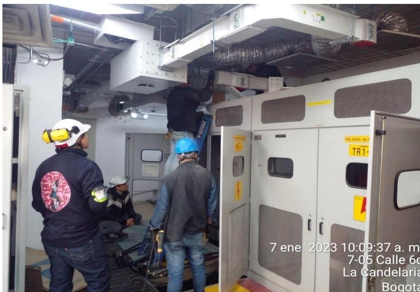
Descripción: Instalación sistema electrobarra, desde transformador #2.
