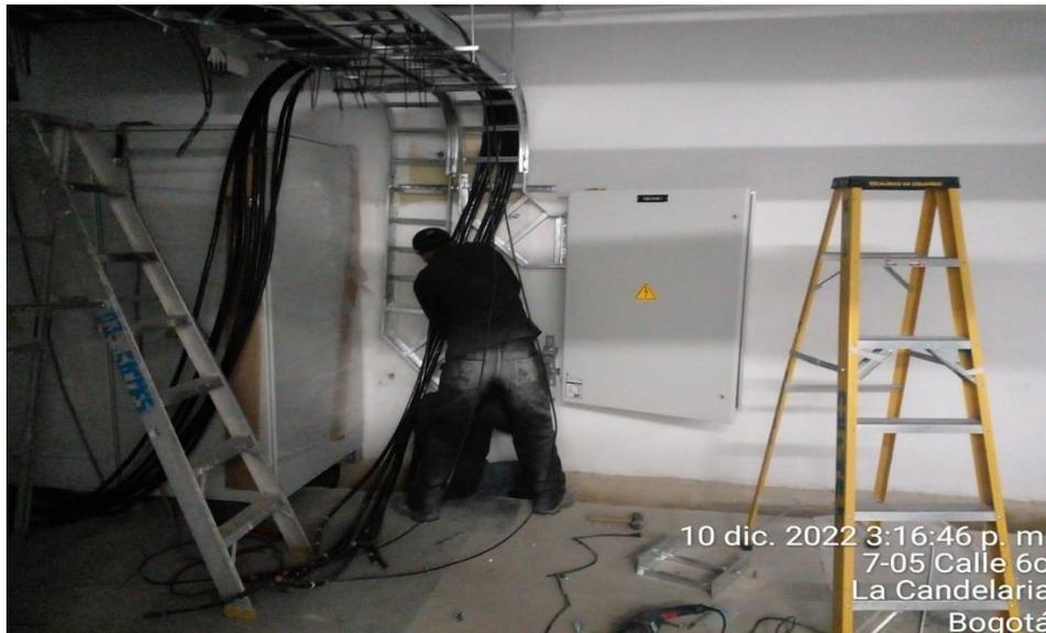
Descripción: Suministro e instalación de alimentador en cable de cobre en 2(3X350+1X350+4T) alojado en bandeja porta cable.
