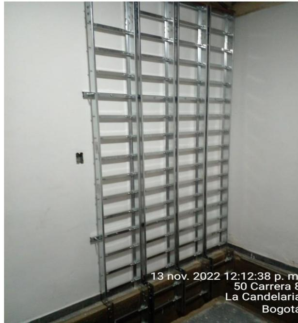
Descripción: Instalación de bandeja tipo ducto de 30x8 cm - Calibre 18 - Pintura electrostática color blanco (sistema normal / sistema regulado) para distribución horizontal (Incluye elementos de sujeción y soportería)
