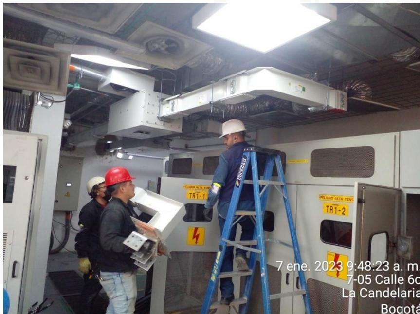
Descripción: Instalación sistema electrobarra, desde transformador #2.
