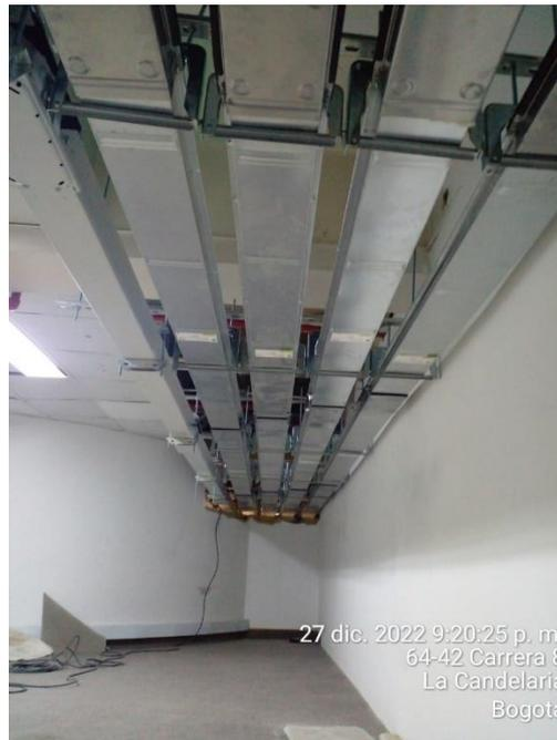
Descripción: Se informa Suministro e instalación electrobarra 315 A, 800A - AL- 3F+N120+T+FE - Aluminio - IP55 - Temp.Ref 40°C. en el cuarto del primer piso, listo para ingresar la actividad de la vertical.
