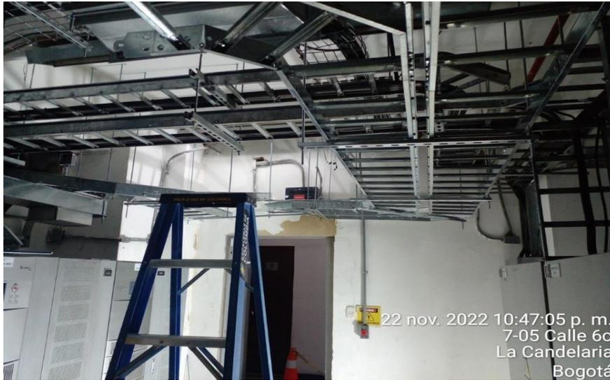
Descripción: Instalación de bandeja tipo ducto de 30x8 cm - Calibre 18 - Pintura electrostática color blanco (sistema normal / sistema regulado) para distribución horizontal (Incluye elementos de sujeción y soportería)
