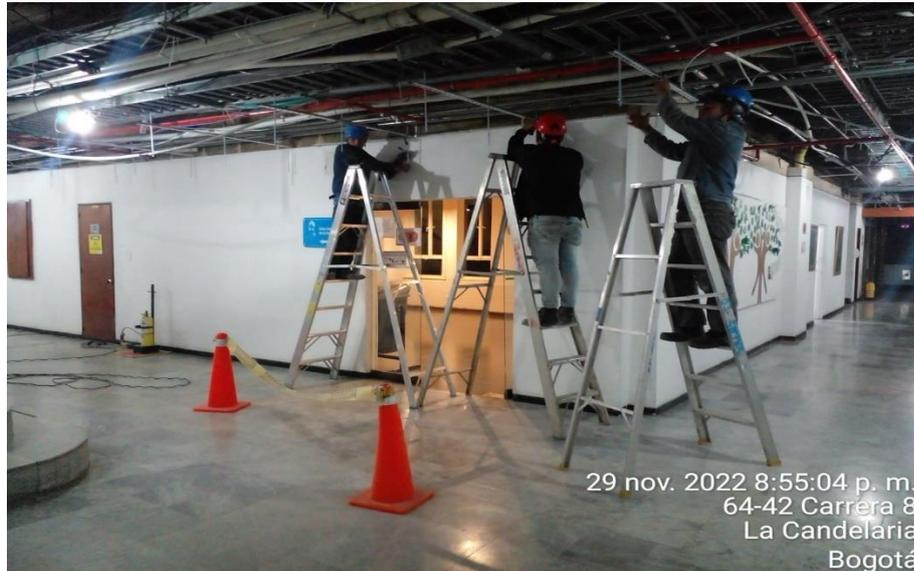
Descripción: Se informa instalación de elementos de sujeción y soportería para la electrobarra en el pasillo adjunto a cuartos de UPS y cafetería.
