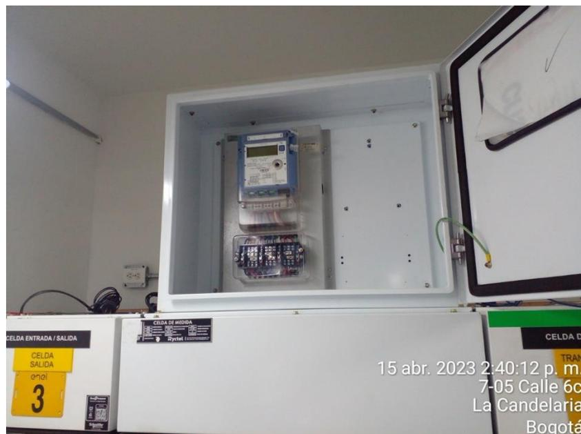
Descripción: Conexión medidor existente en celda grupo de medida.
