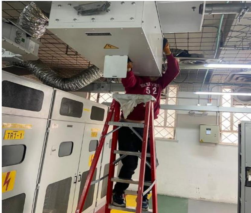
Descripción: Cierre breaker para prueba transferencia planta, transformador 2.
