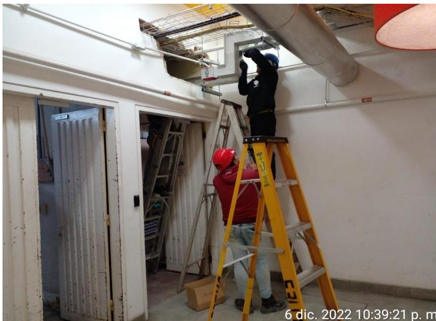
Descripción: Suministro e instalación de codo horizontal electrobarra 1600A AL- 3F+N+T+TE - Aluminio - IP55 - Temp.Ref 40°C - Libre de halógenos - Auto-extinguible - aislamiento 130°C - (Incluye elementos de fijación, bloques y accesorios de instalación)
