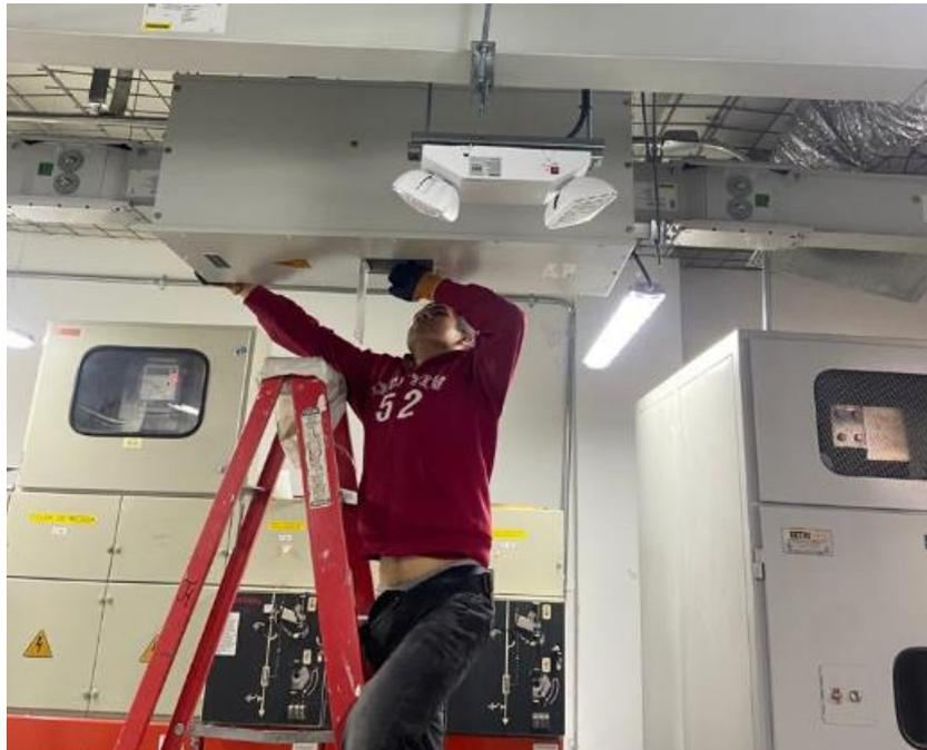
Descripción: Apertura breaker para prueba transferencia planta, transformador 1.
