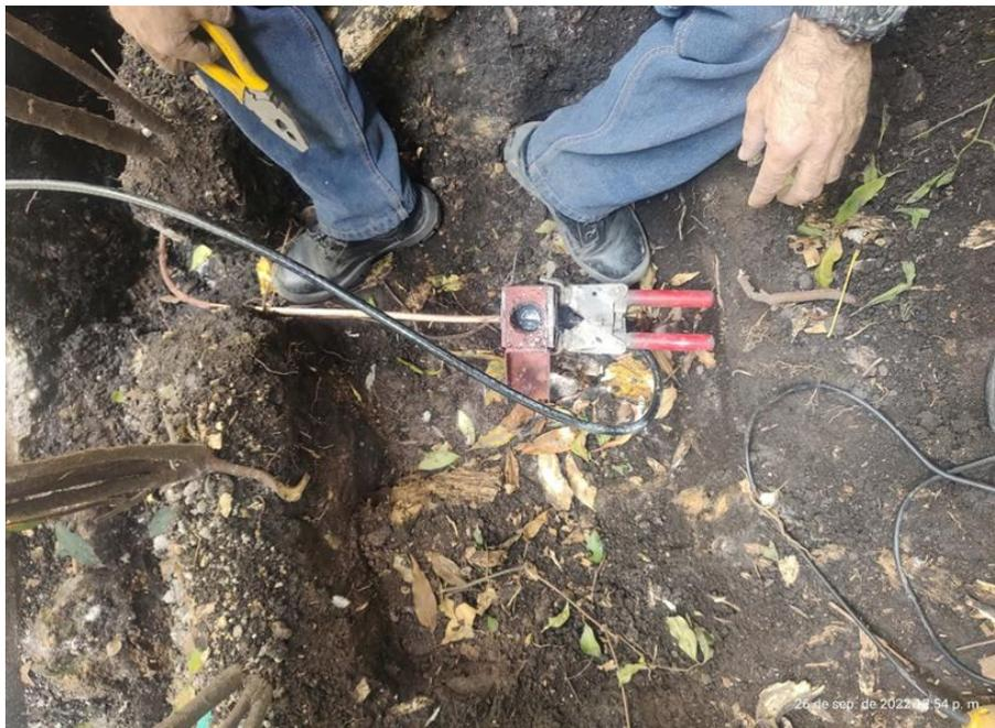
Soldadura varillas anillo STP apantallamiento.
