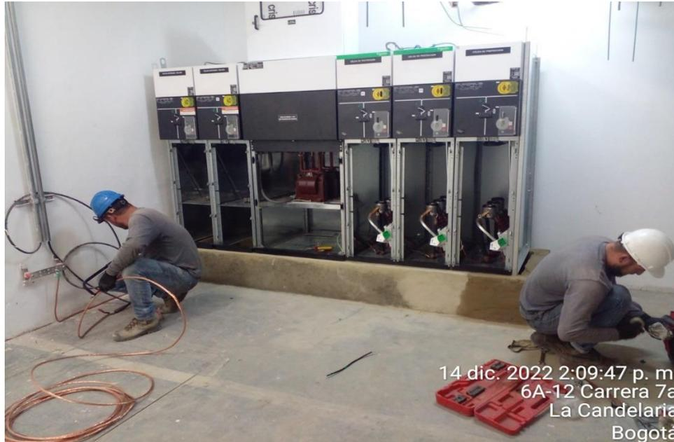
Descripción: Suministro e instalación de celda de salida en media tensión 630A aislamiento SF6 - 15kV - Icc=25KA
