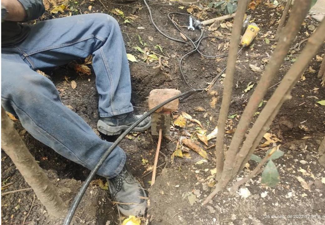
Soldadura varillas anillo STP apantallamiento.
