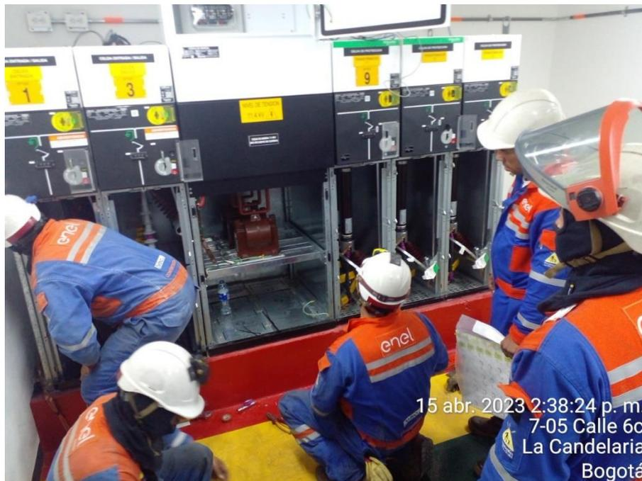
Descripción: Conexión alimentador existente a celdas nuevas.
