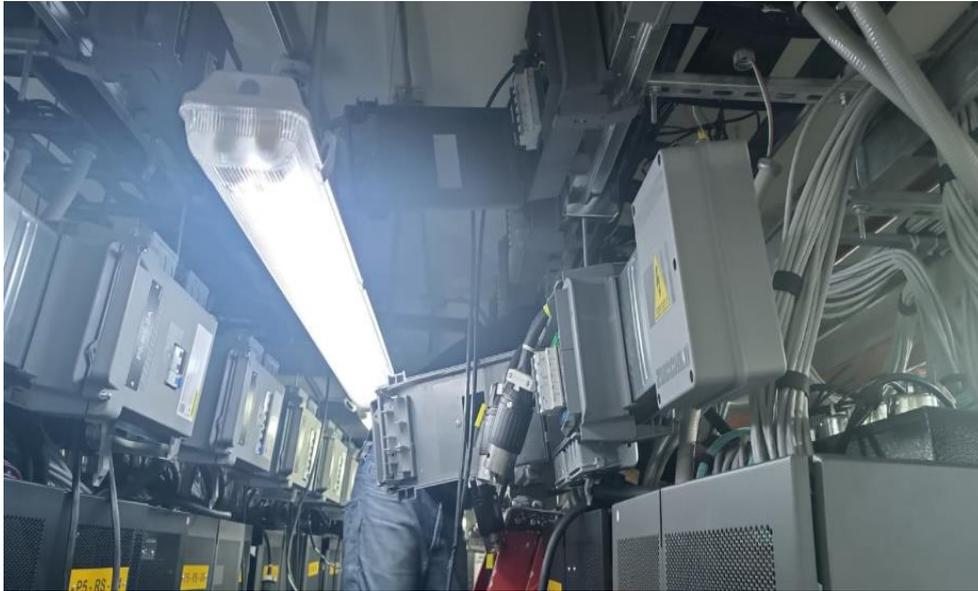
Descripción: Instalación cajas derivación Electrobarras, Data-center piso 5.
