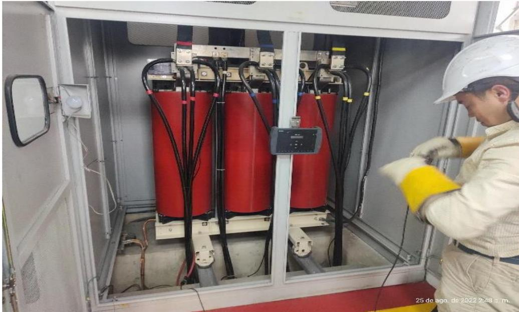
Descripción: Se realiza la conexión de equipos analizadores de red con el fin de chequear cargas consumidas por cada uno de los transformadores de la subestación (Imagen transformador 3).
