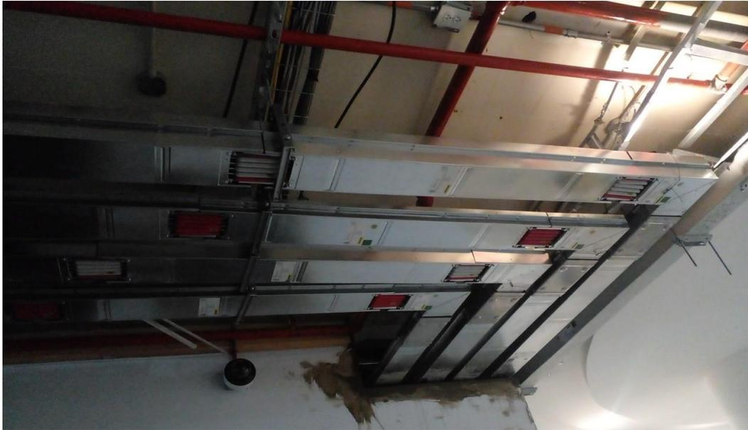
Descripción: Se informa Suministro e instalación de tramo alimentador sin derivaciones electrobarra 315A - AL- 3F+N120+T+FE - Aluminio - IP55 - Temp.Ref 40°C - Libre de halógenos - Auto-extinguible - aislamiento 130°C - Tramo 3 m (Incluye elementos de fijación, bloques y accesorios de instalación)
