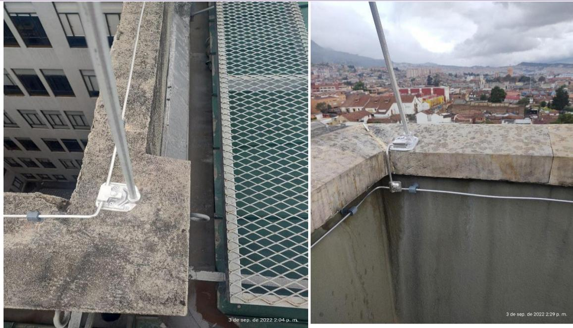
**Descripción:** Se realiza instalación de puntas captadoras con sus respectivos accesorios en cada una de las terrazas.
