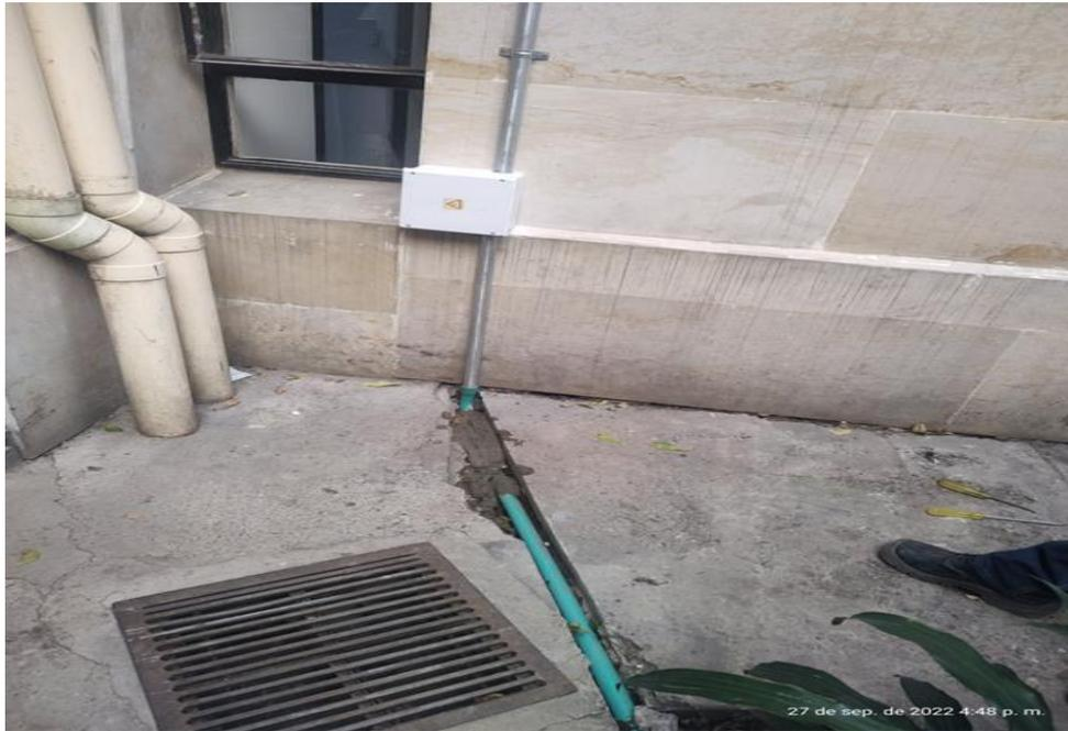
Instalación cajas para derivación alambón con SPT patio sur.
