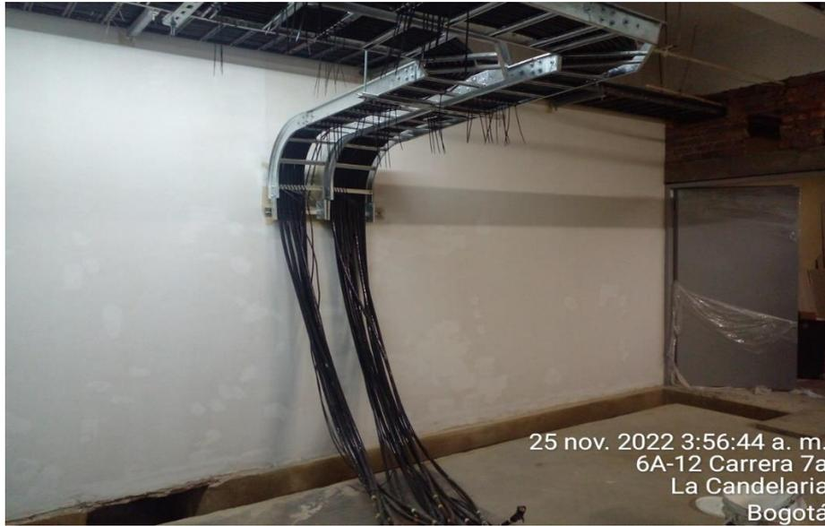
Descripción: Se informa tendido de cableado en la bandeja porta cable en el nuevo cuarto técnico de la subestación.
