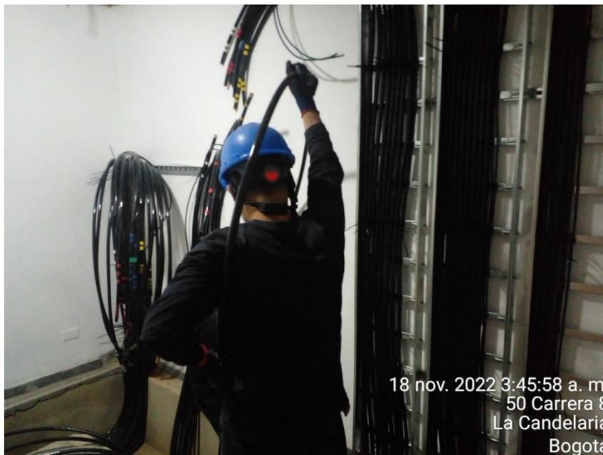
Descripción: Instalación de acometida en cable de cobre, adjunto en cuarto técnico de ups de 100 Kva y de 200 Kva, adjunto a cafetería de sótano
