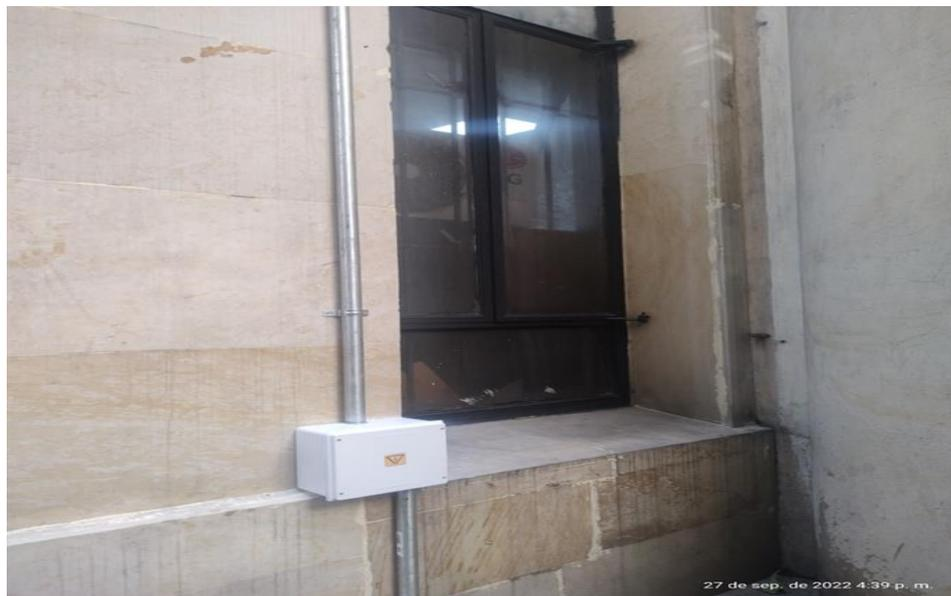
Instalación cajas para derivación alambros con SPT patio sur.
