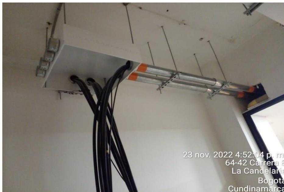
Descripción: Instalación de acometida en cable de cobre.
