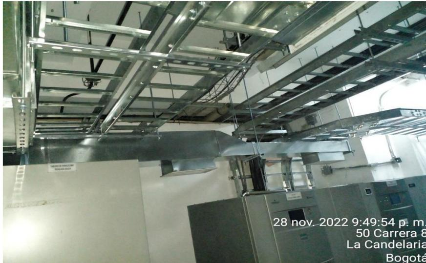
Descripción: Se informa instalación de elementos de sujeción y soportería para la blinda barra
