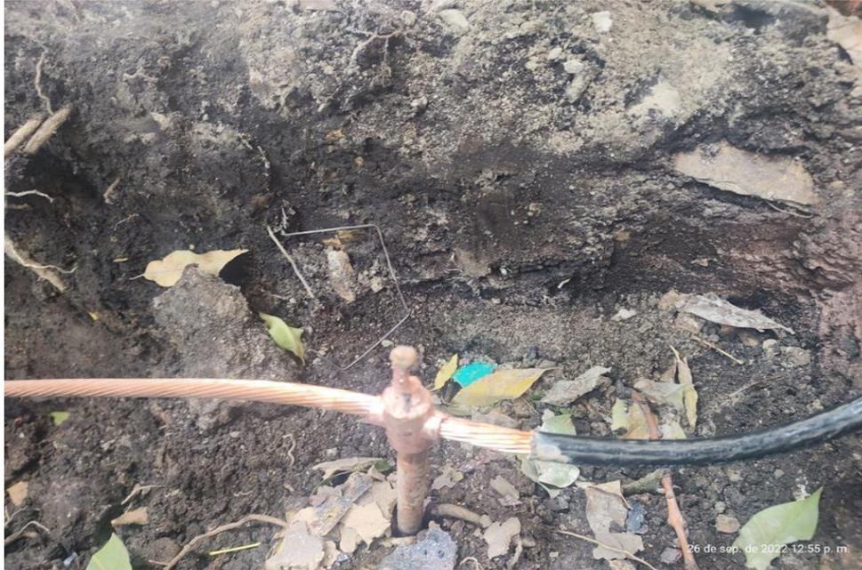
Soldadura exotérmica varillas cooper well.
