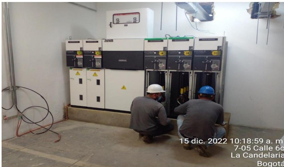
Descripción: Se informa Suministro e instalación de celda de medida en media tensión 630A aislamiento SF6 - 15kV - Incluye TP's (208V/120V) y TC's (2,5 (20)A) - medición de kVAh y kVArh - Borneras de prueba
