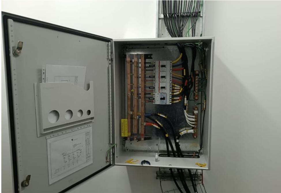
Descripción: Estado tablero con marquillas, diagrama unifilar y manual usuario.
