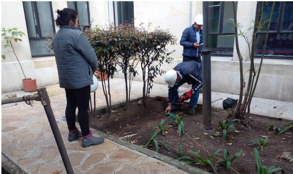
Descripción: Se informa de las pruebas realizadas por el inspector RETIE del sistema puesta tierra del sistema de apantallamiento.
