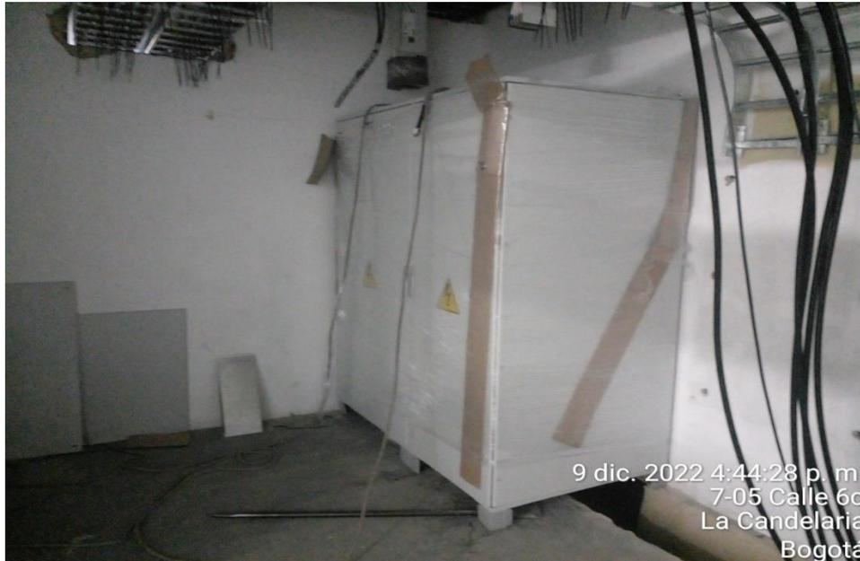
Descripción: Instalación de tablero de distribución TG-PLANTA - (Tablero de fabricación especial auto soportado), en el nuevo cuarto técnico de subestación.
