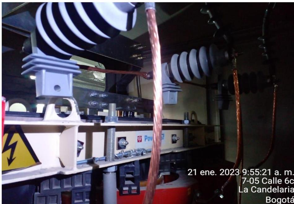
Descripción: DPS de transformador con soporte permanente.
