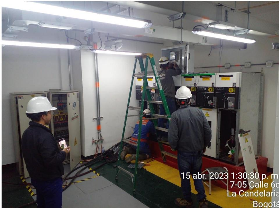
Descripción: Conexión alimentador existente a celdas nuevas.
