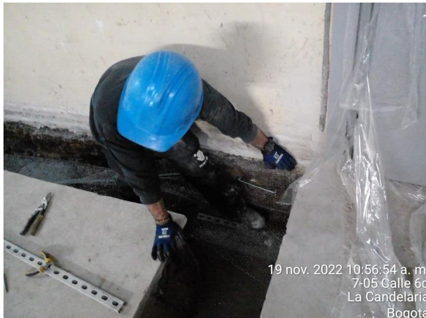
Descripción: Se informa de la limpieza, trazo, nivelación, excavación de cárcamo en sótano que se ubica en cuarto nuevo de subestación
