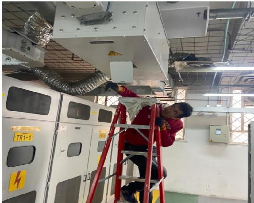
Descripción: Apertura breaker para prueba transferencia planta, transformador 2.
