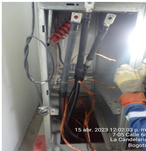
Descripción: desconexión alimentador existente de celdas antiguas.
