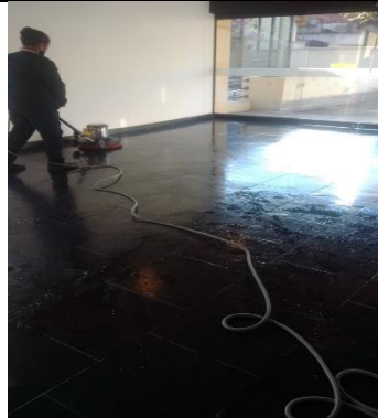
Lavado de pasillos Y lavado de escaleras Tecnología 1 y 2 Sede Casas de Santa Bárbara.
