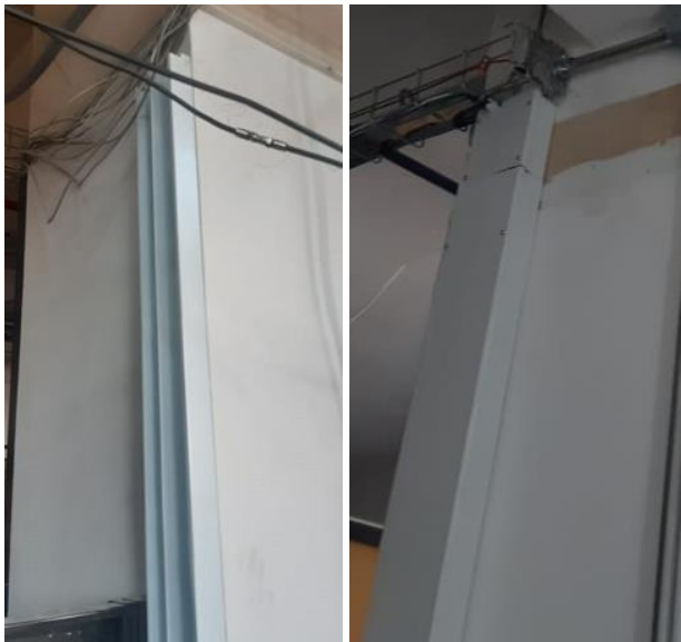
Instalación de infraestructura nueva (Bajantes sobre muro)
