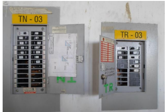
Reorganización de circuitos eléctricos en tableros de distribución
