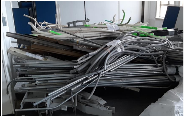
Desinstalación de infraestructura obsoleta
