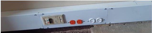
Instalación de infraestructura nueva (Bajantes y canaleta perimetral)
