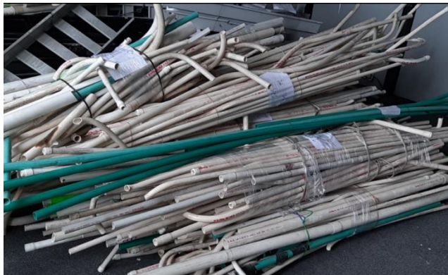
Desinstalación de infraestructura obsoleta
