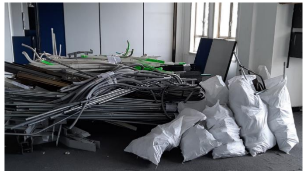
Desinstalación de infraestructura obsoleta
