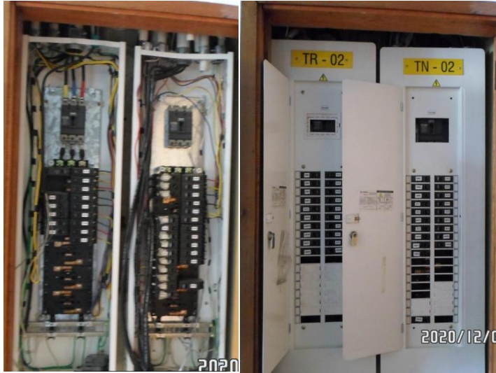
Reorganización de circuitos eléctricos en tableros de distribución
