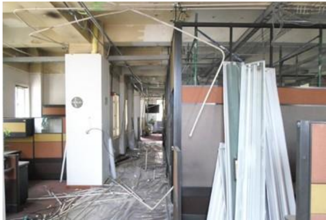
Desinstalación de infraestructura obsoleta
