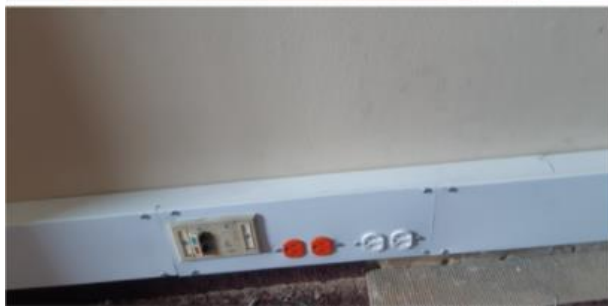
Instalación y reorganización de circuitos y tomas eléctricas de puestos de trabajo
