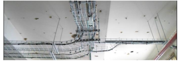
Instalación de infraestructura nueva (Bandejas portacable, tubería EMT y accesorios)
