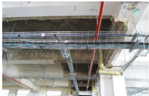
Instalación de infraestructura nueva (Bandejas portacable, tubería EMT y accesorios)
