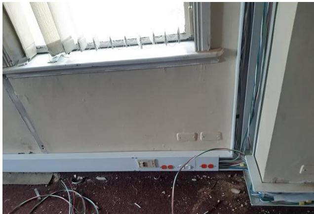
Instalación de infraestructura nueva (Bandejas portacable, tubería EMT y accesorios)
