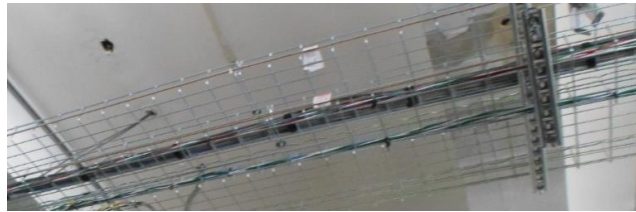
Instalación de infraestructura nueva (Bandejas portacable, tubería EMT y accesorios)
