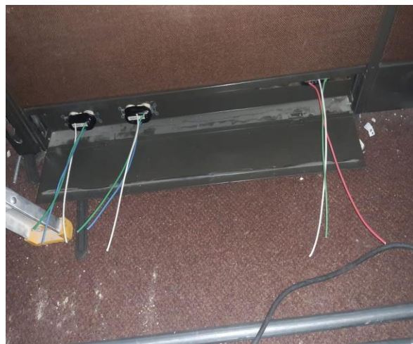
Instalación y reorganización de circuitos y tomas eléctricas de puestos de trabajo
