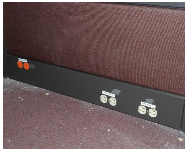
Terminación. Adecuación de canaletas y tomas eléctricas
