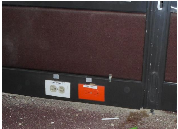
Terminación. Adecuación de canaletas y tomas eléctricas
