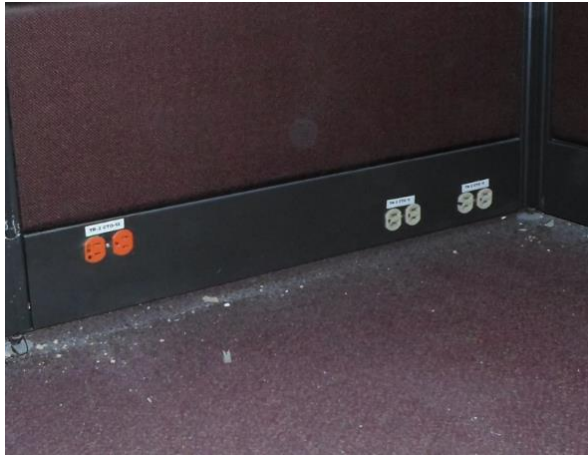
Terminación. Adecuación de canaletas y tomas eléctricas
