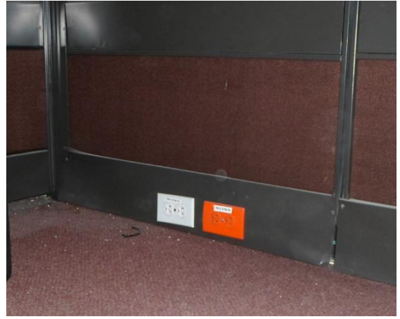
Terminación. Adecuación de canaletas y tomas eléctricas
