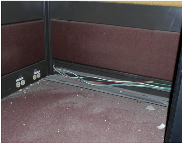
Instalación y reorganización de circuitos y tomas eléctricas de puestos de trabajo
