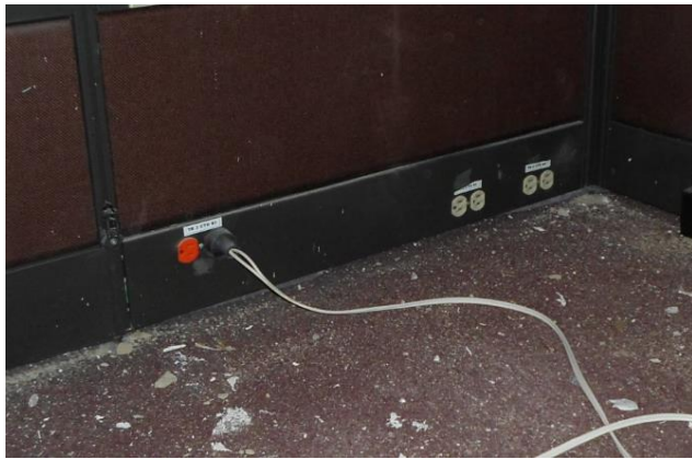
Terminación. Adecuación de canaletas y tomas eléctricas
