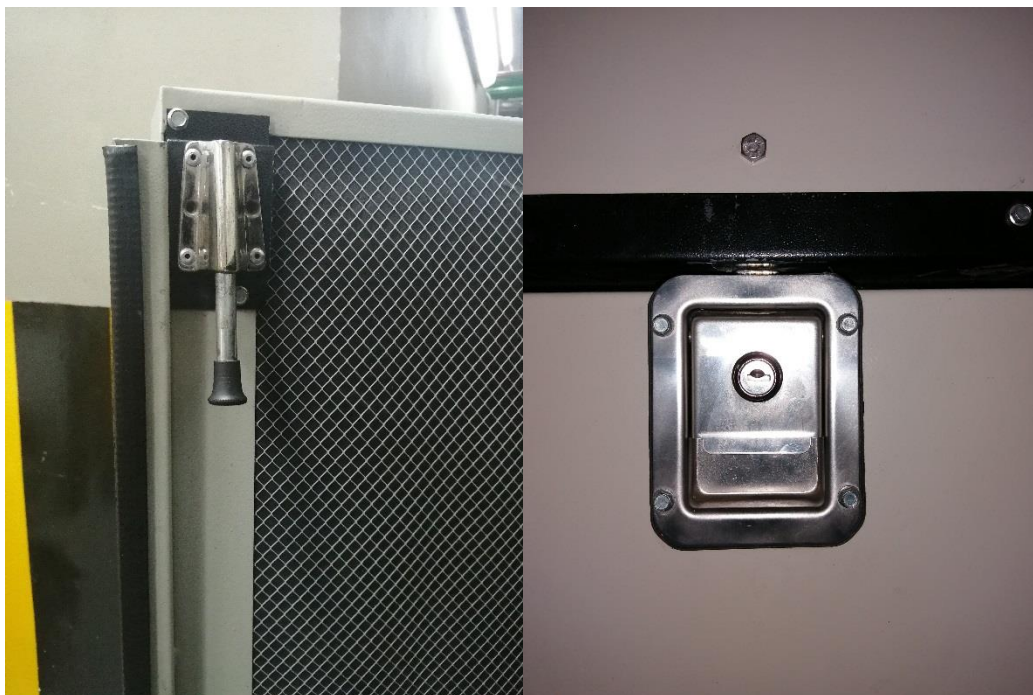
Imagen 11. Seguros y chapas de seguridad gastados
