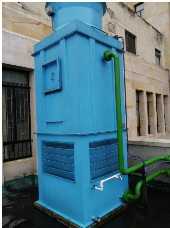
Imagen 8. Torre de enfriamiento después de la limpieza
