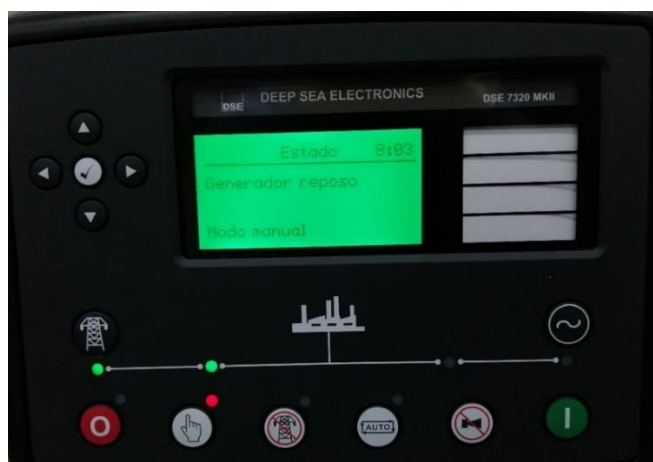
Imagen 2. Planta eléctrica en modo manual.
