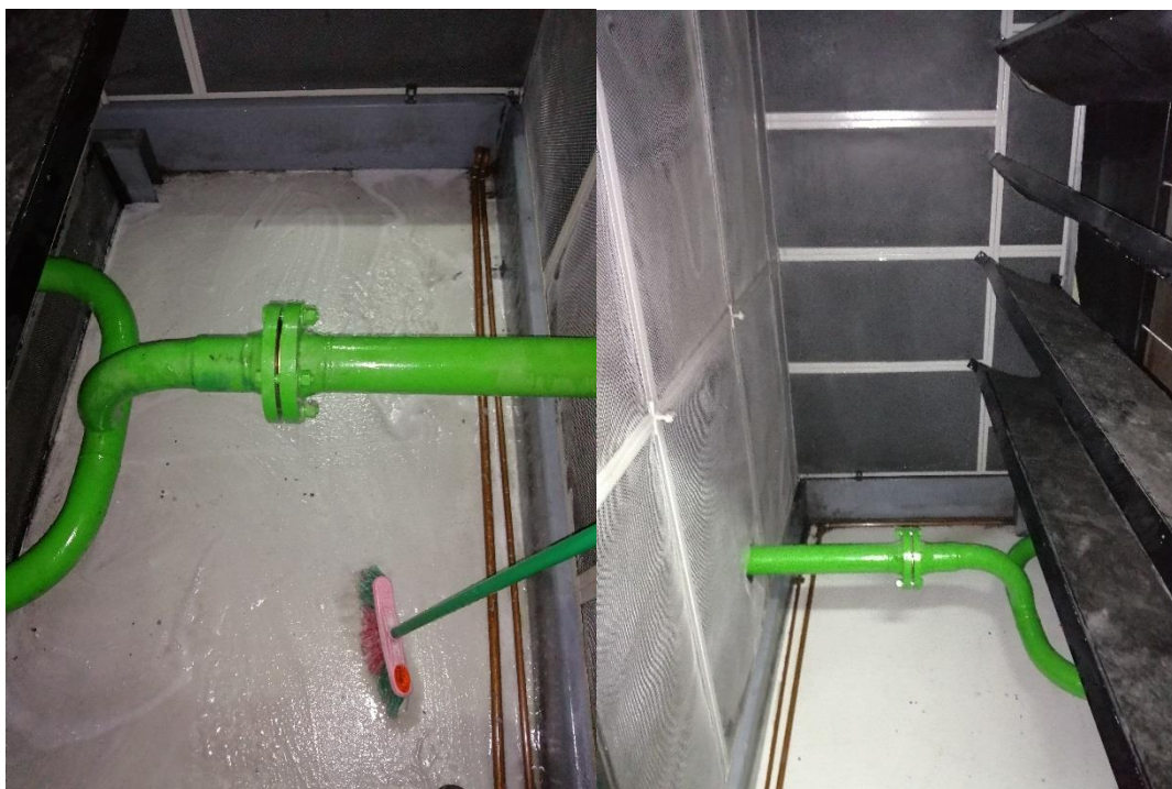
Imagen 6. Limpieza de las cabinas de la planta eléctrica
