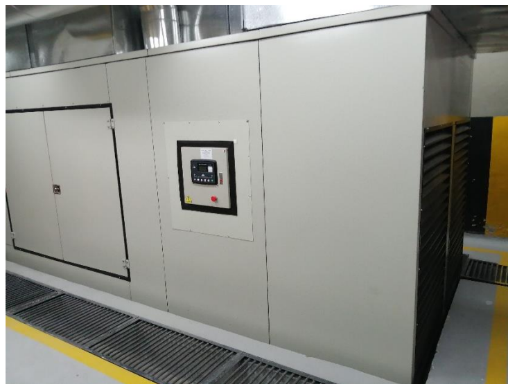
Imagen 1. Planta Eléctrica PERKINS de 1200 KVA
