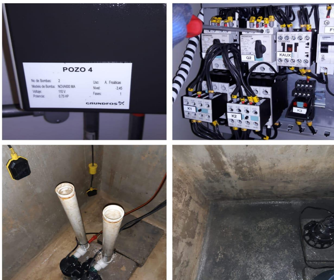
FIGURA 8 POZO 4 EQUIPO NIVEL FREATICO
