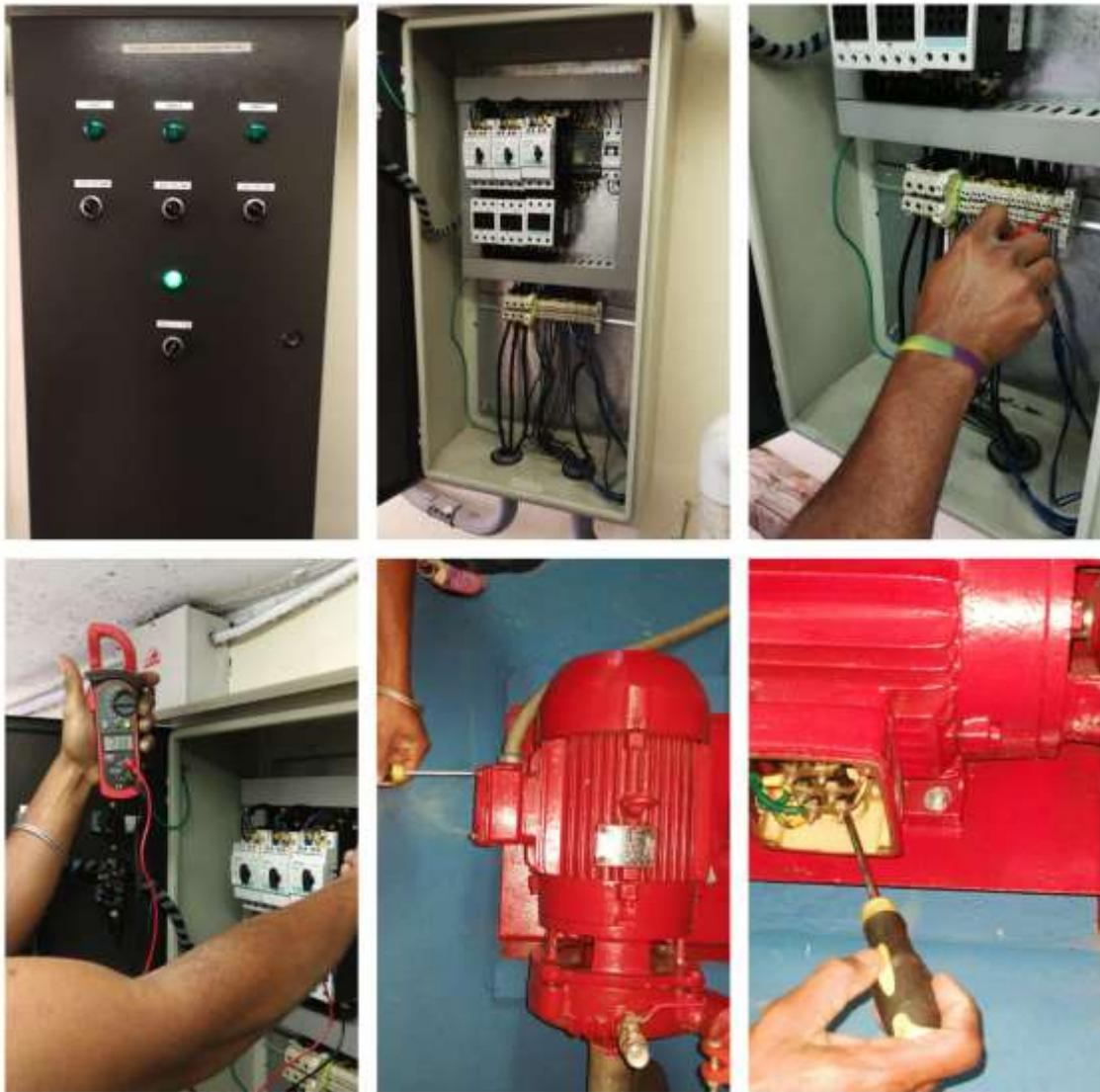
Figura 1 Equipo de presión agua potable
