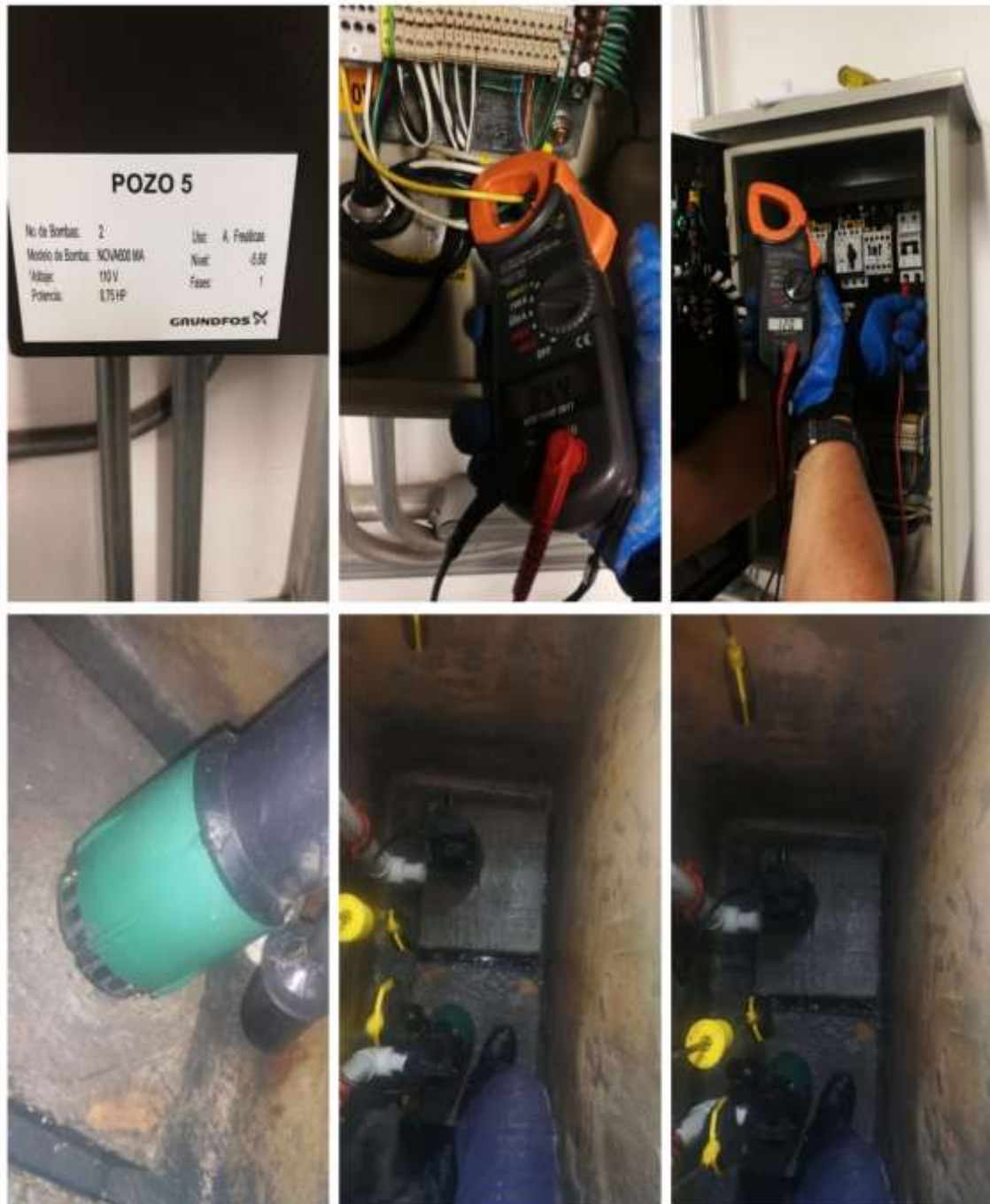
FIGURA 9 POZO 5 EQUIPO DE NIVEL FREÁTICO
