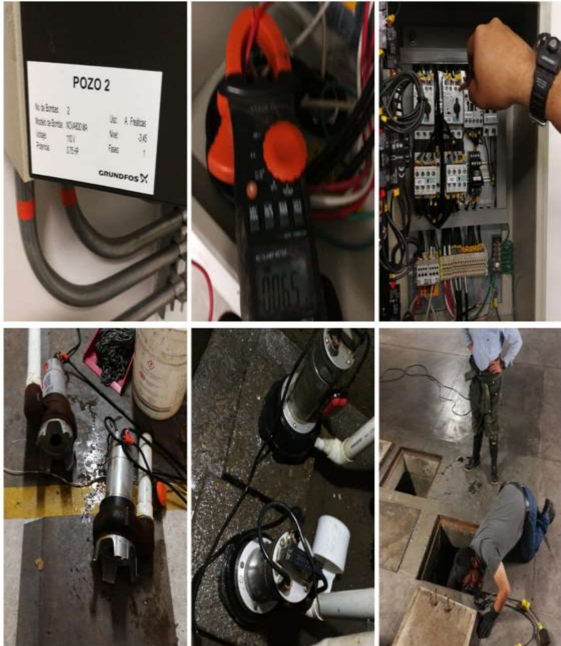
FIGURA 6 POZO 2 EQUIPO DE NIVEL FREATICO
