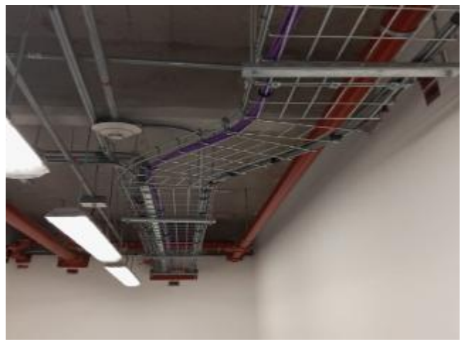
Tendido horizontal de cable F/UTP
