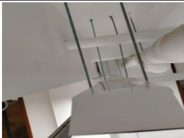
Instalación de canaleta en techo
