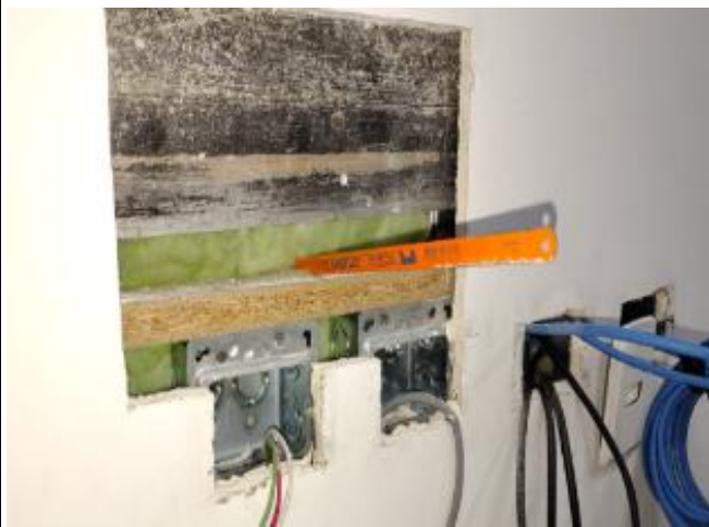
Corte de drywall e instalación de cajas
