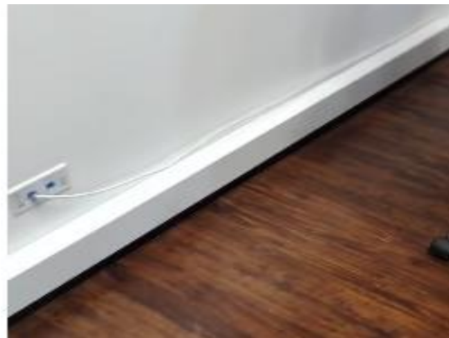
Instalación de canaleta perimetral
