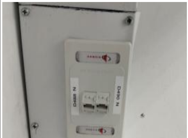
Terminación y marquillado
