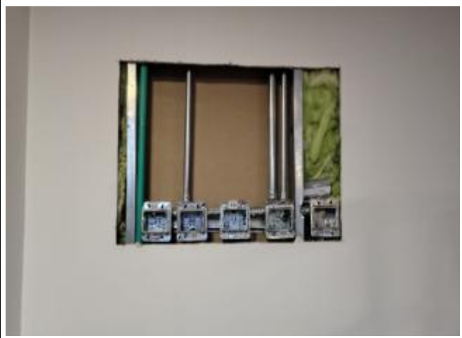
Apertura de muro e instalación de tubería y accesorios
