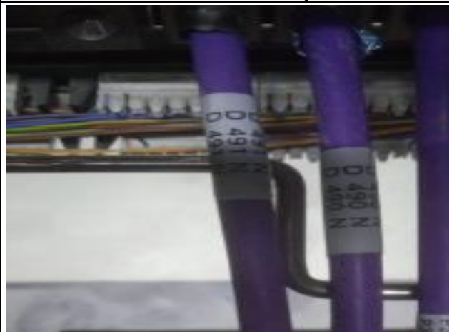
Instalación y marquillado de cable F/UTP
