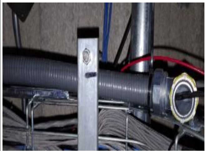
Instalación de cable HDMI
