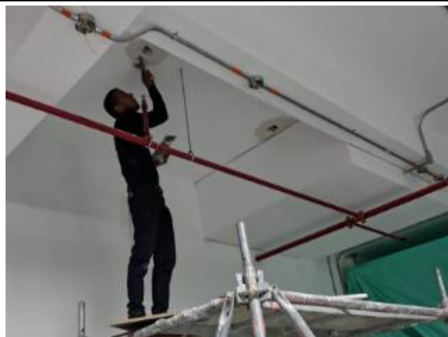
Perforación y resane de placa
