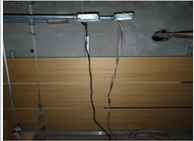
Instalación de tubo EMT y cajas
