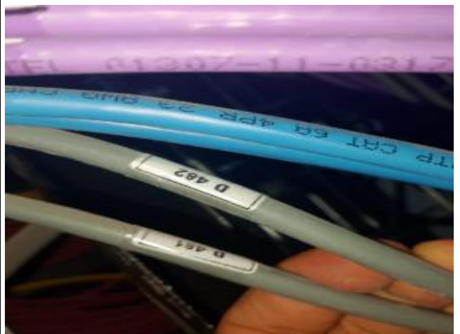
Inspección en patch panel
