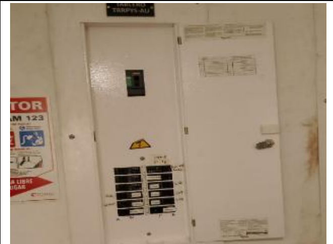
Instalación y marquillo de breakers en tablero
