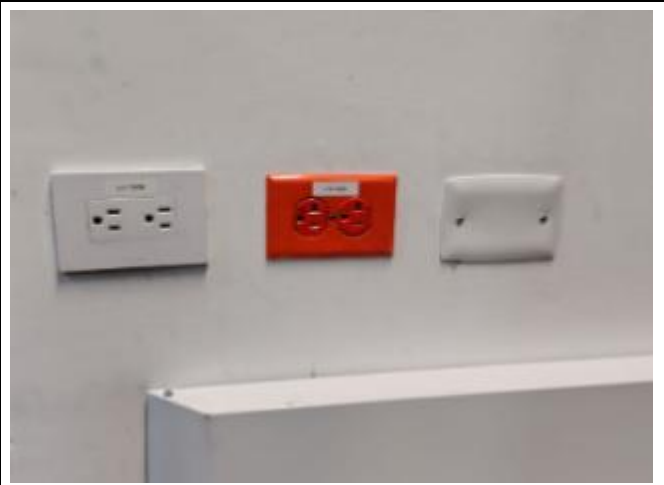
Instalación de canaleta perimetral
