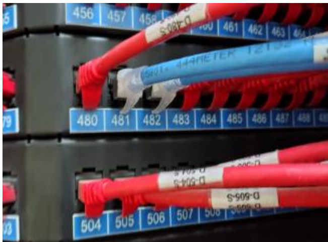
Instalación y ,maquillado de patch cords en rack
