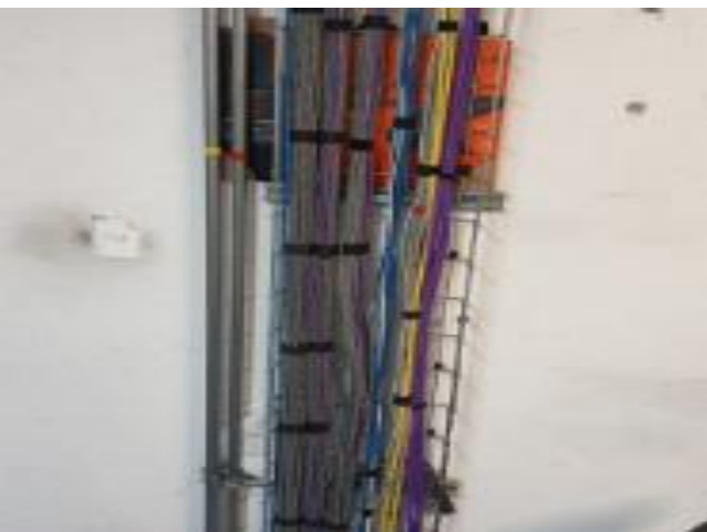
Tendido vertical de cable F/UTP
