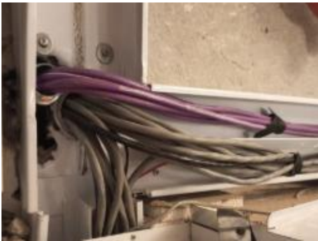
Perforación de muro e instalación de cable F/UTP
