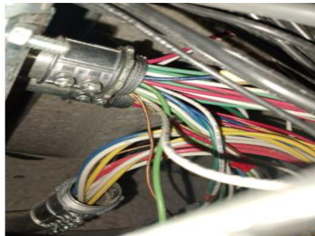
Instalación de cable eléctrico
