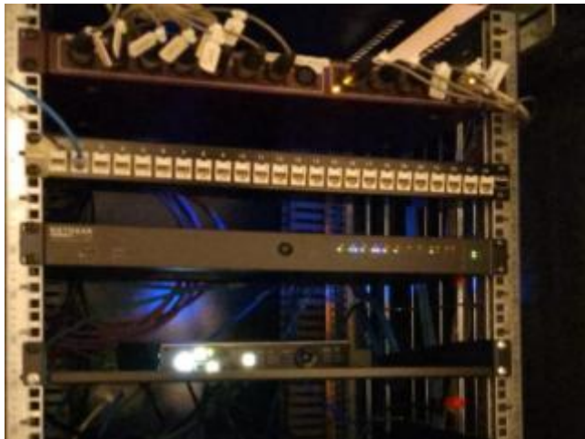
Instalación de patch panel
