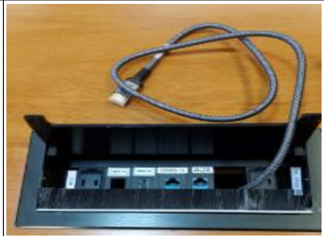
Instalación de cable HDMI
