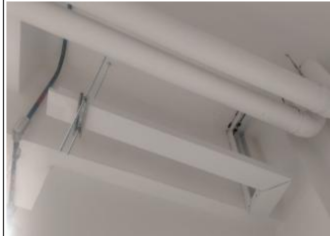
Instalación de canaleta en techo
