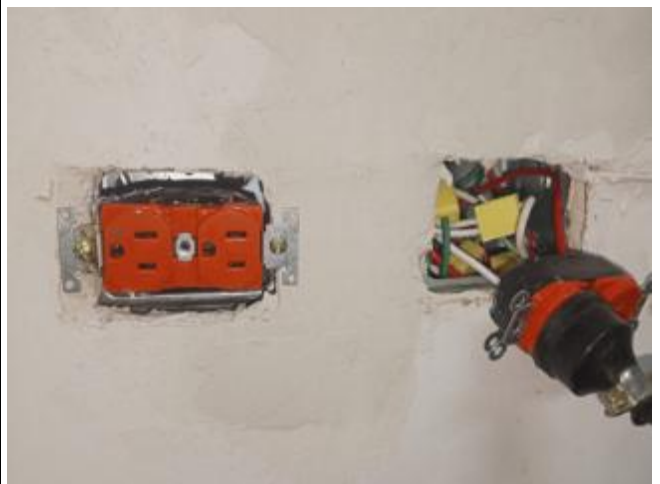
Instalación de tomas eléctricas
