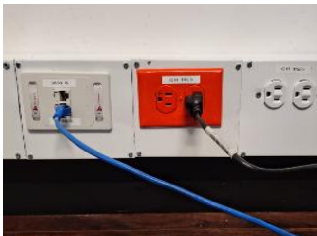
Puntos de red y tomas eléctricas reubicados
