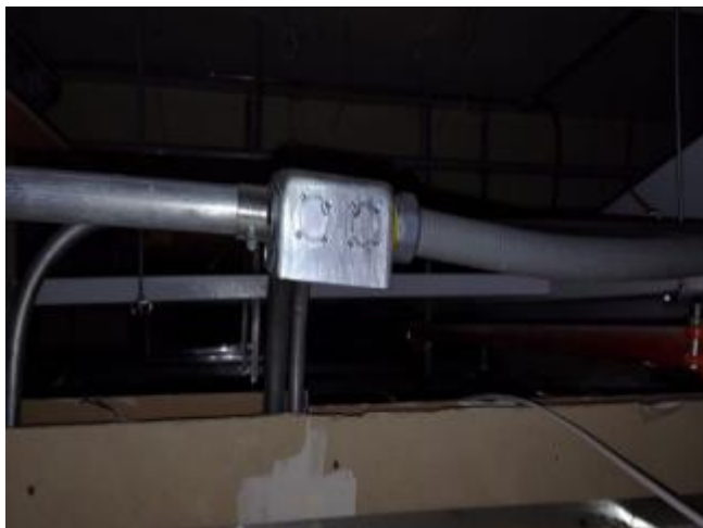
Instalación de coraza, caja y accesorios
