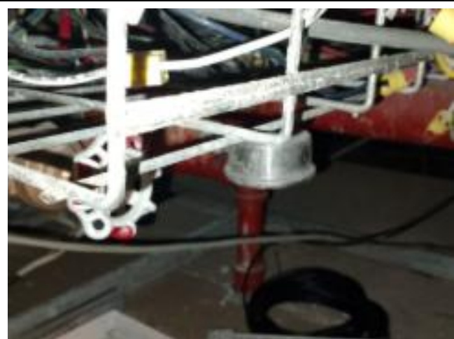
Instalación de cable HDMI
