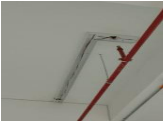
Instalación de canaleta en techo y cableado
