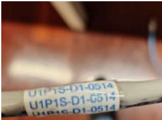
Inspección estado de cable horizontal
