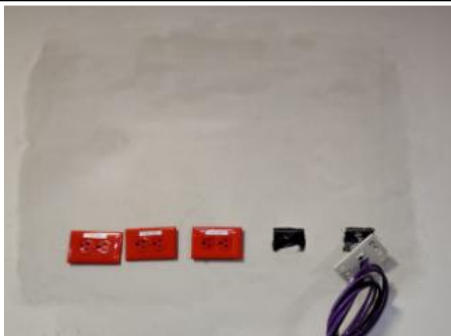
Marquillado de tomas e instalación de cable HDMI
