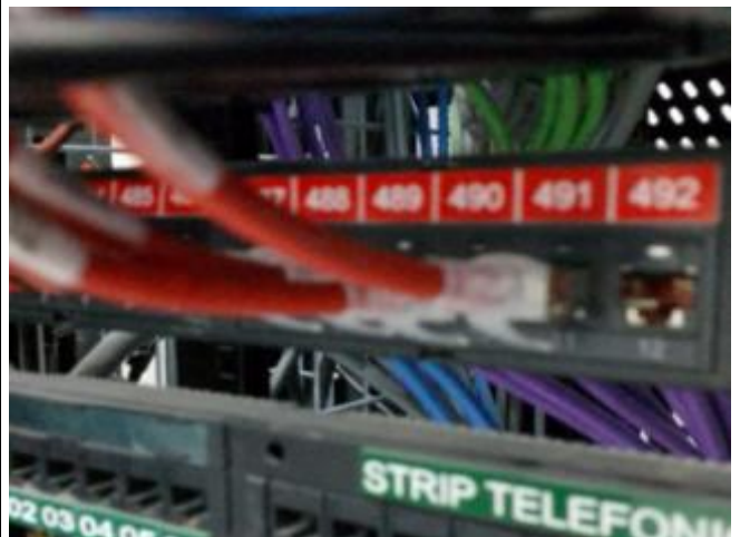
Instalación y marquillado de patch cords en rack
