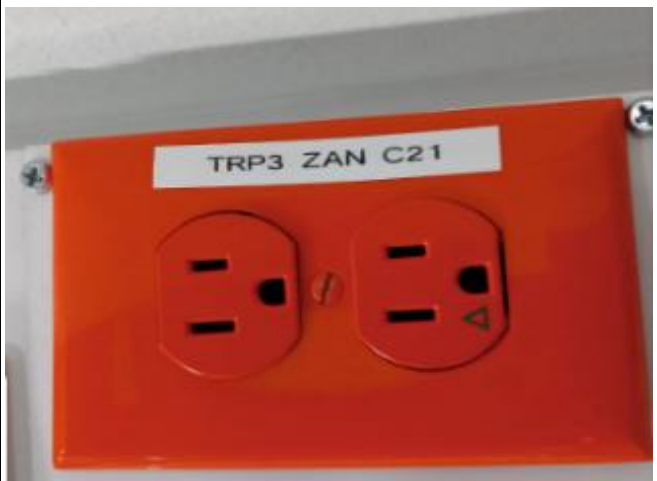
Instalación de toma regulada en techo
