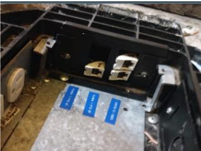
Reparación de puntos en caja de piso (tarima)
