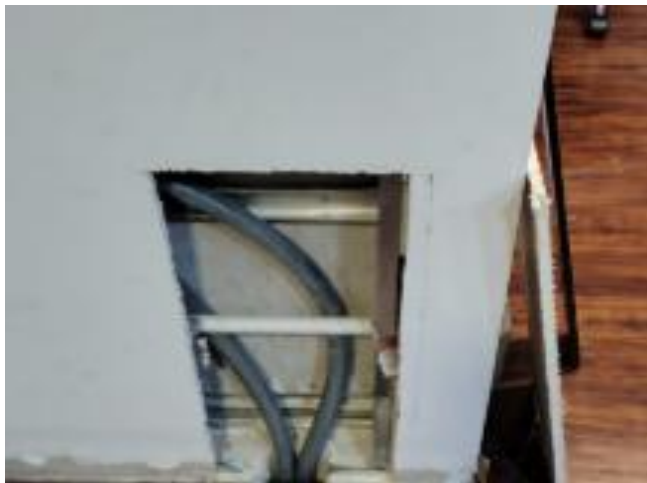
Instalación de coraza metálica
