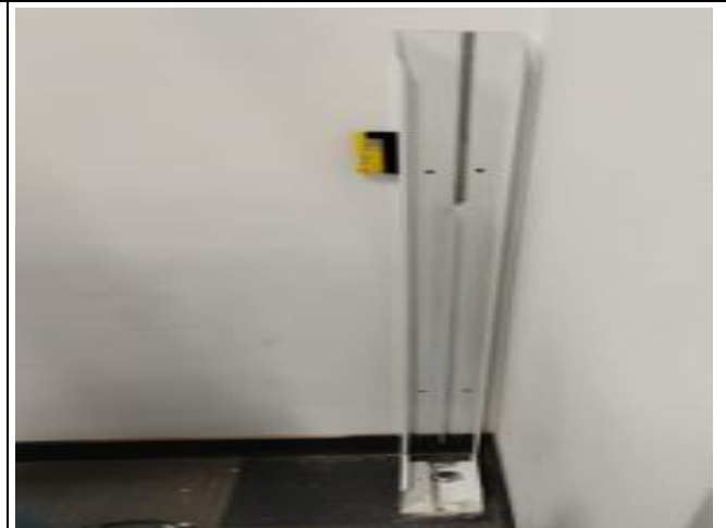
Perforación de placa e instalación de canaleta
