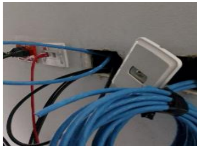
Instalación de cable F/UTP y HDMI
