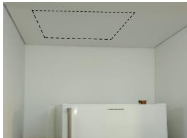
Inspección y plan de trabajo (ventana de inspección)
