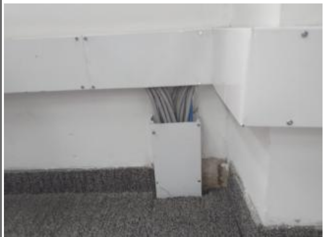
Inspección de bajante a Piso 7
