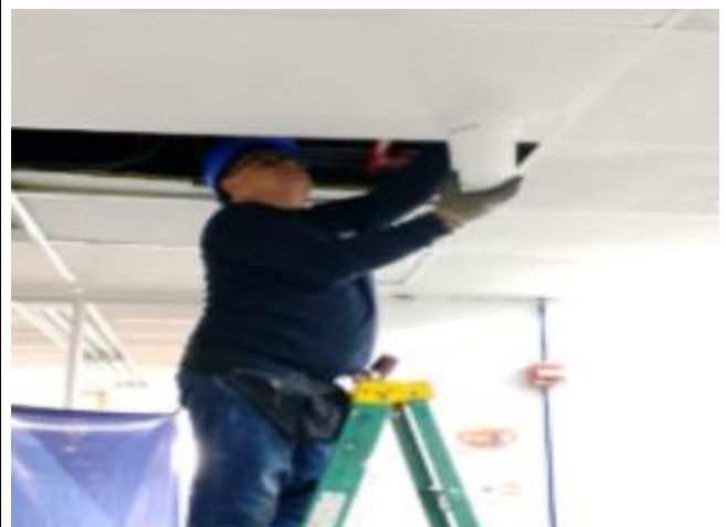
Desinstalación de equipos
