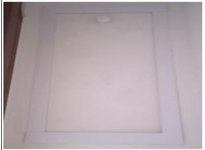
Instalación ventana de inspección (bajante)
