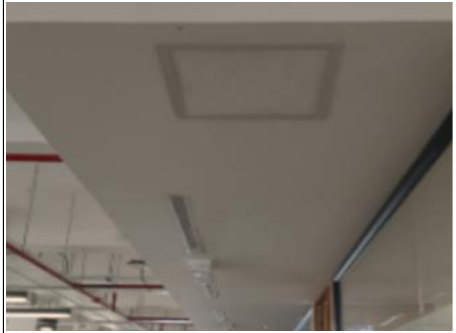
Corte e instalación de ventanas de inspección
