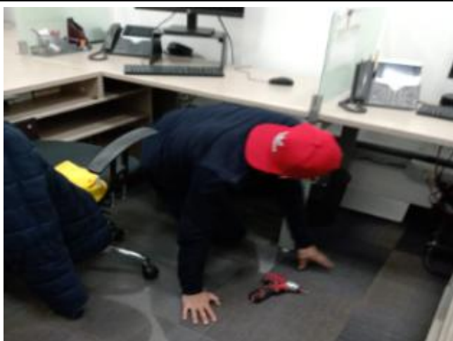
Instalación de cable F/UTP
