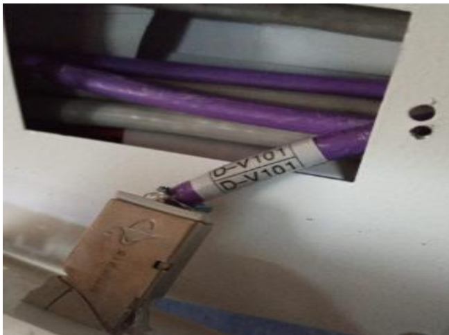
Ponchado y marquillado en puesto de trabajo
