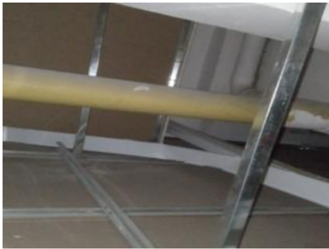
Inspección de canaletas
