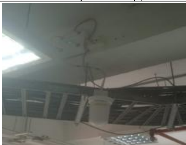
Identificación y ubicación de equipos
