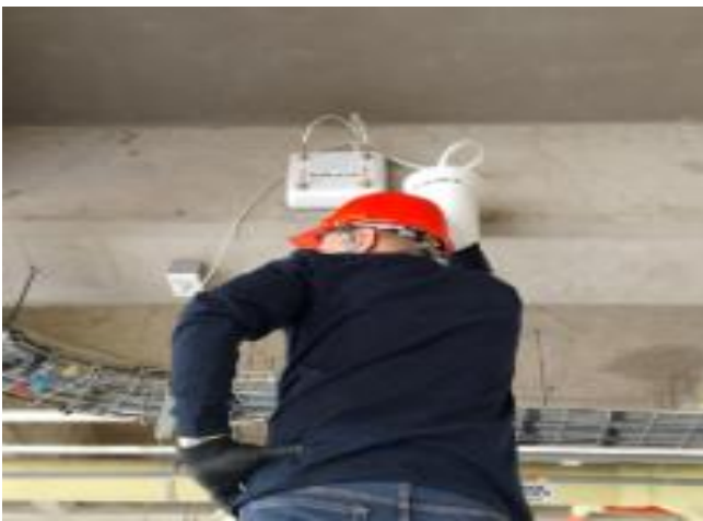
Desinstalación de equipos
