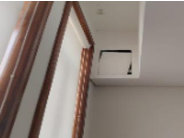
Corte ventana de inspección (bajante)
