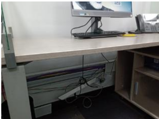
Instalación de cable F/UTP
