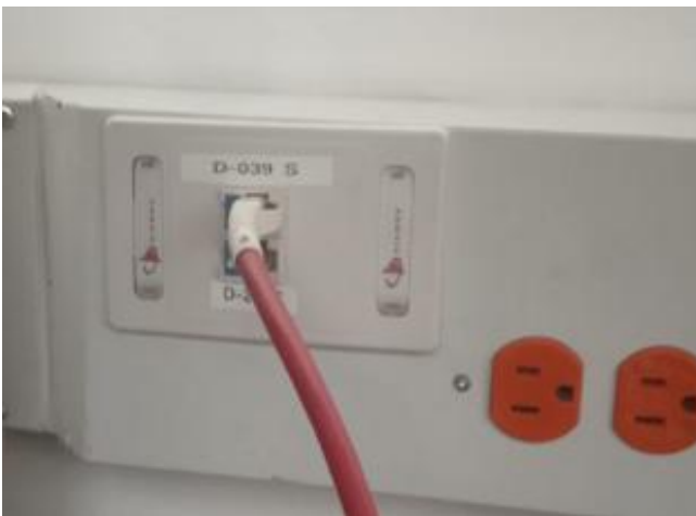
Instalación y marquillado de faceplates
