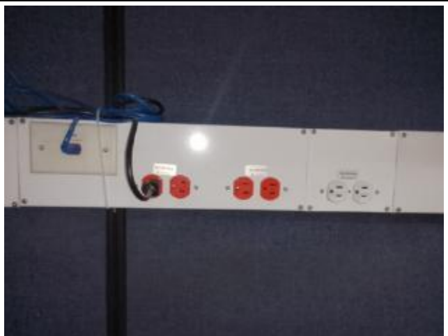
Inspección de puesto de trabajo
