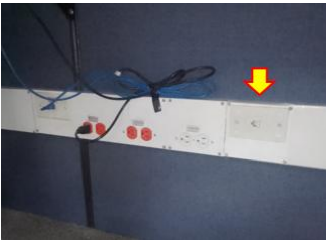
Instalación de troquel y faceplate
