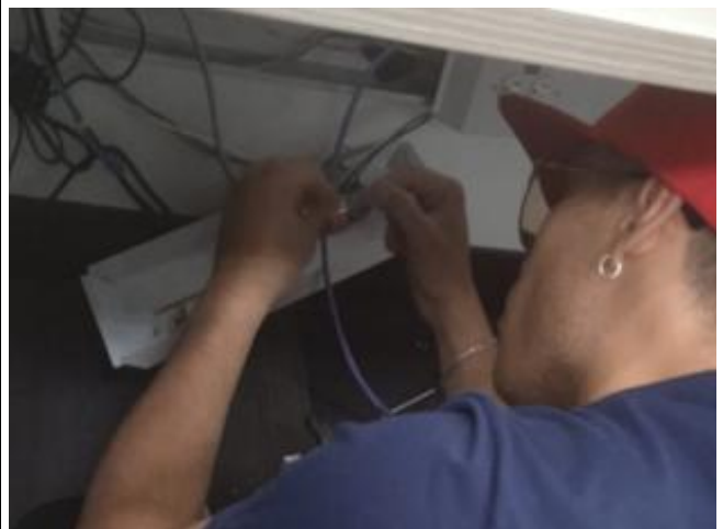
Ponchado y marquillado en puestos de trabajo
