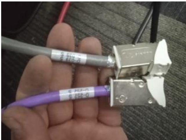
Ponchado y marquillado en puestos de trabajo
