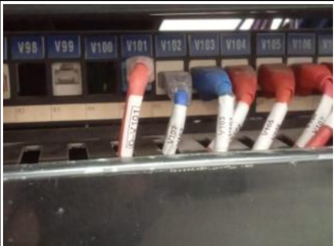
Instalación y marquillado de patch cord
