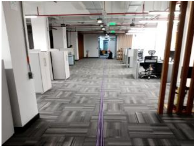
Instalación de cable F/UTP
