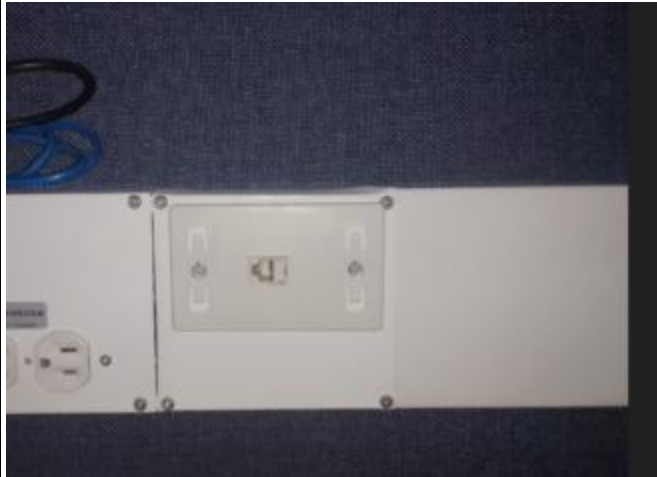
Instalación de troquel y faceplate
