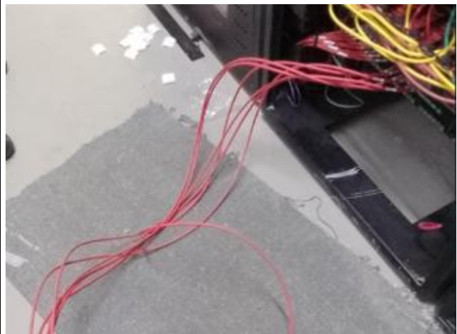
Instalación y marquillado de patch cords
