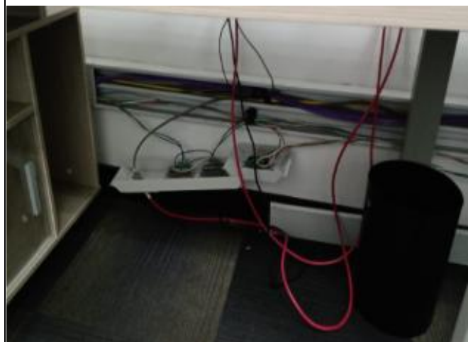
Instalación de cable F/UTP
