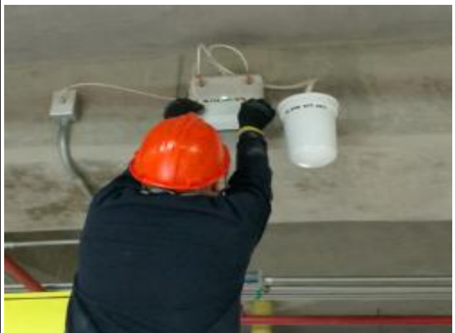
Desinstalación de equipos
