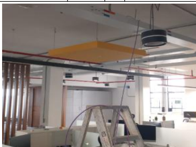
Instalación de cable F/UTP
