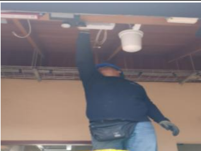
Desinstalación de equipos
