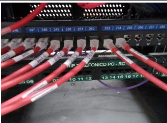
Instalación y marquillado de patch cords
