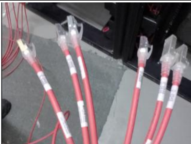
Instalación y marquillado de patch cords
