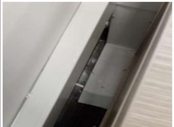
Inspección de bajante a Piso 2
