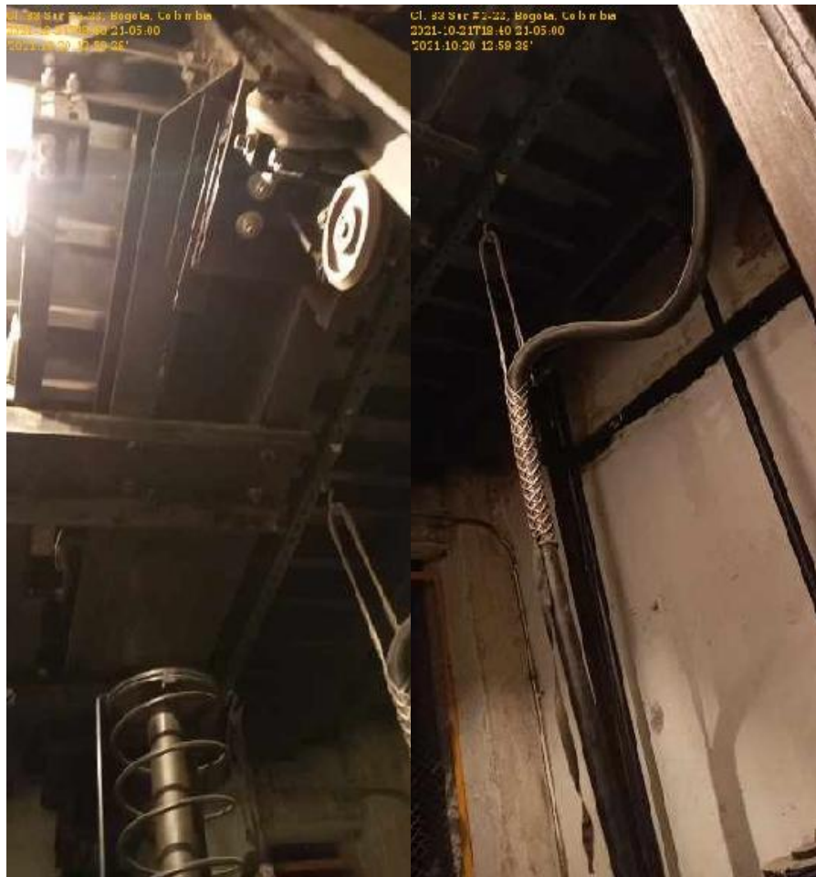
Parte inferior de la Cabina - Después
