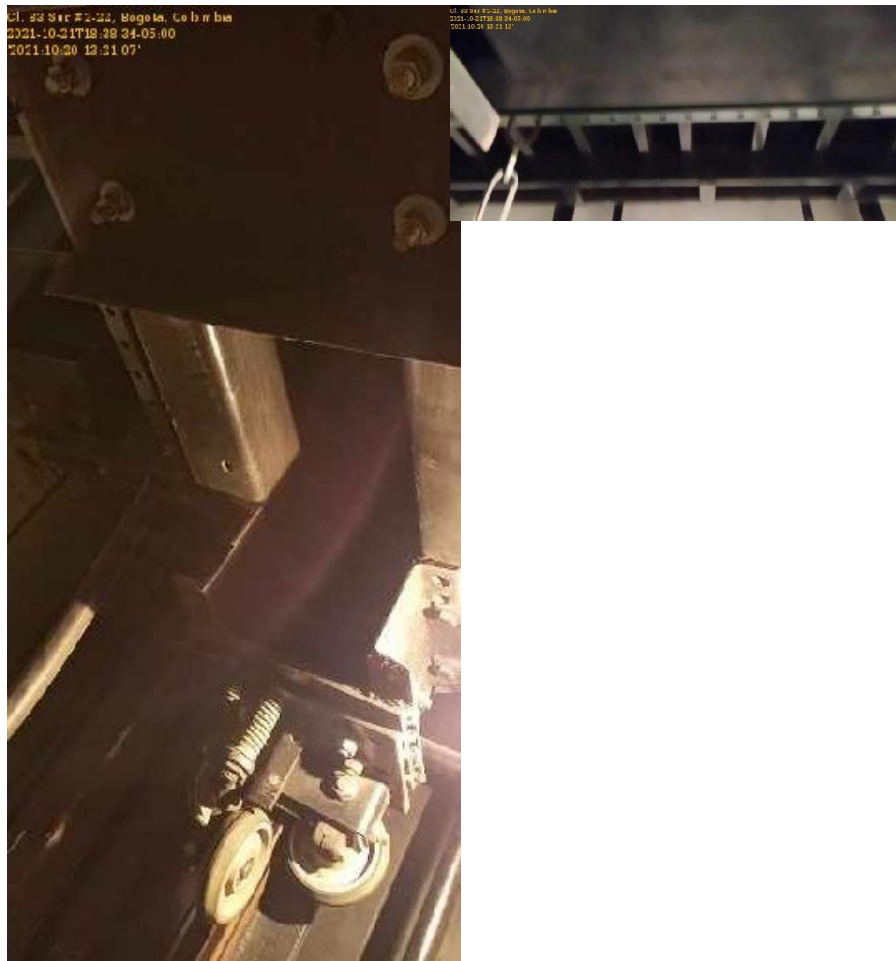
Parte inferior de la Cabina - Después
