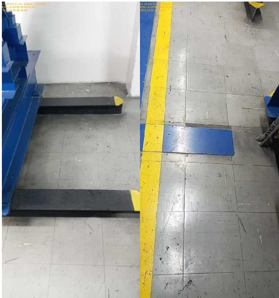
Cuarto de Maquinas - Después
