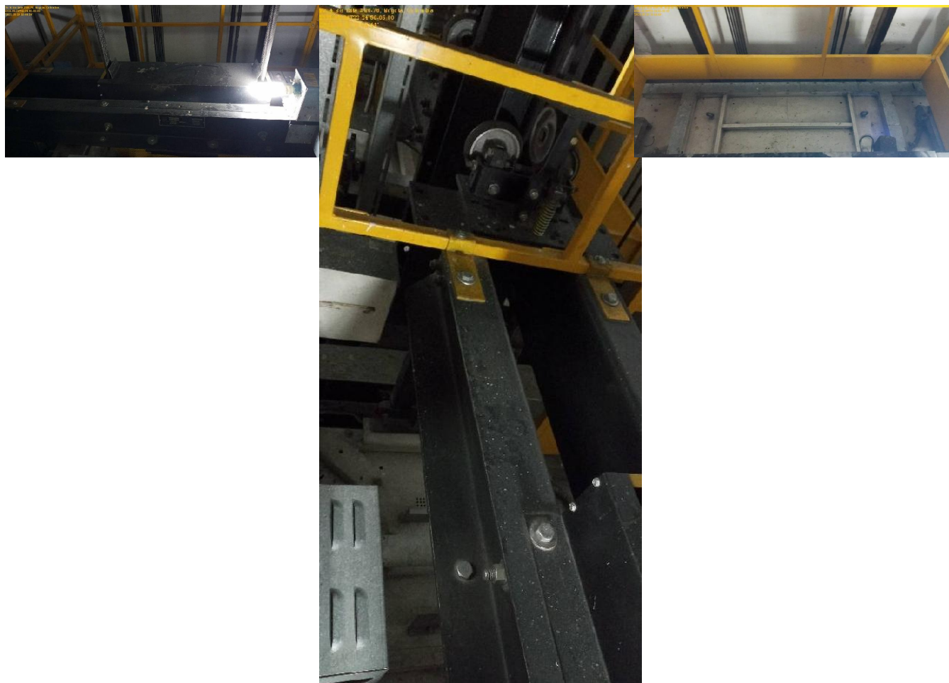
Techo de la Cabina - Después
