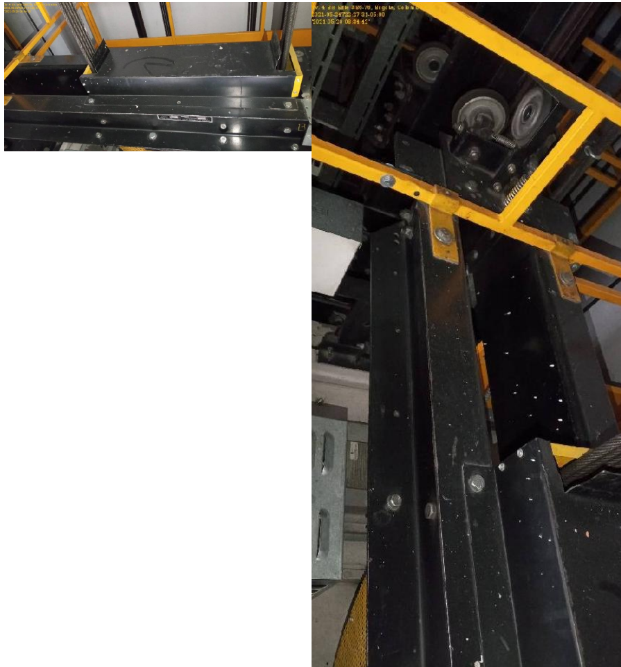
Techo de la Cabina - Después
