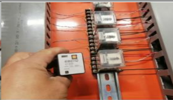
Se hace cambio de relevo reestableciendo el servicio de los 4 semáforos
