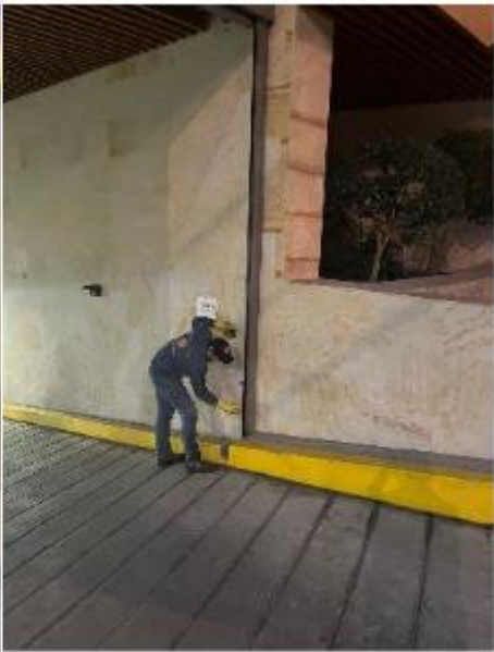
Evidencia de engrase en los rieles del sistema, toma de voltaje en las tarjetas controladoras y motores se encuentran en óptimas condiciones. Sistema de cadena y rieles en buen estado
