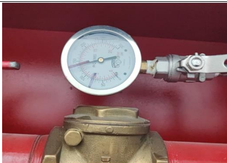
140 psi sótano costado sur
