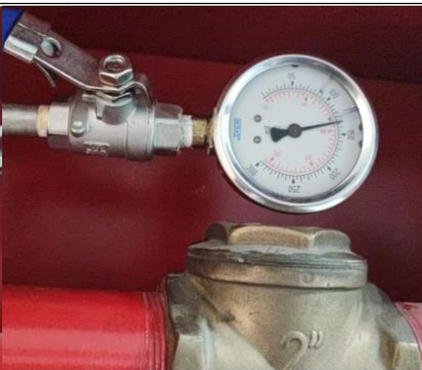
135 psi sótano costado norte
