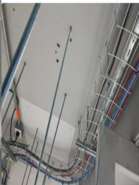
1 Cableado encauchetado
