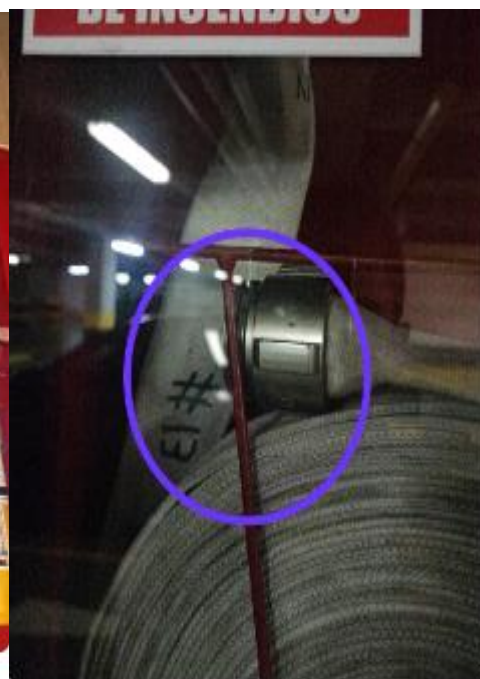
Elementos de gabinetes se reporta cambio de boquilla chorro niebla de 1 1/2" en bronce x 150 psi UL/FM gabinete #13
