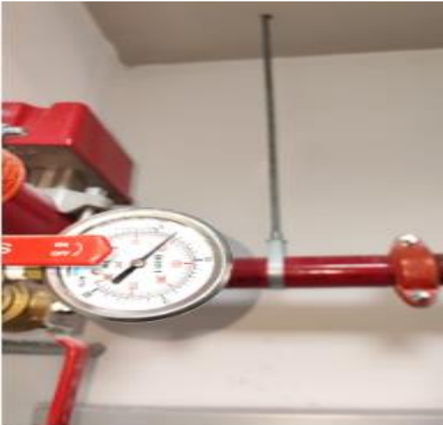
Lectura de manómetros estaciones de control ( cronograma marzo) piso 6 /95 psi
