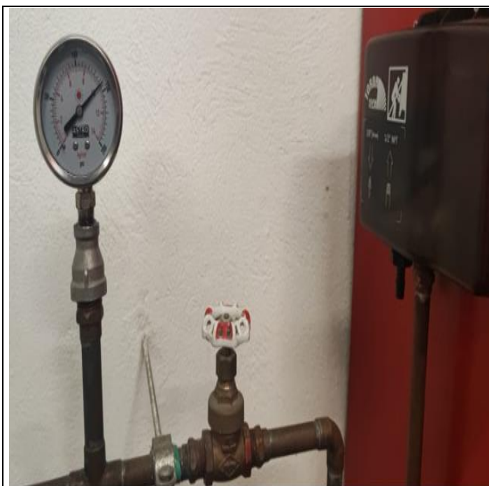
Línea de sendedo bomba principal 145 psi
