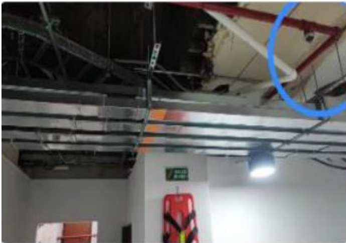
Área frente a streep telefónico sótano
