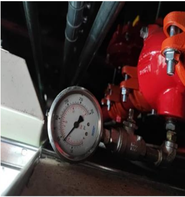
Lectura de manómetros estaciones de control ( cronograma marzo) piso 8 /85 psi
