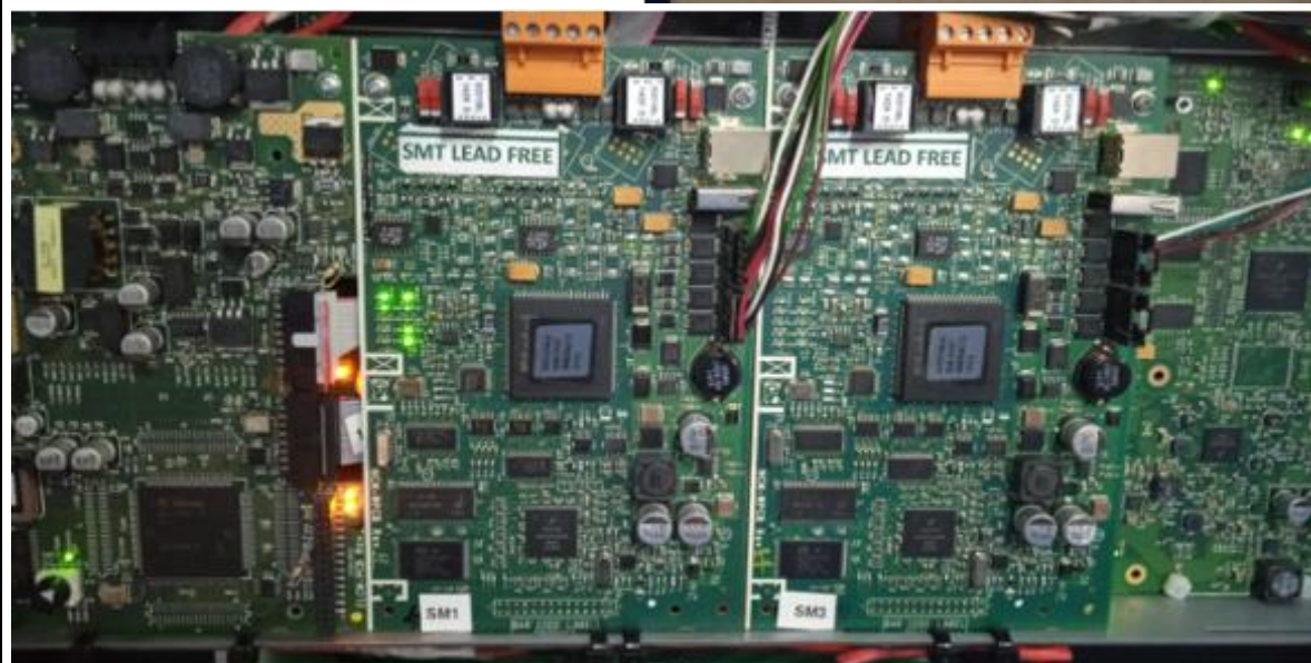
Colocación de nuevas tarjetas
