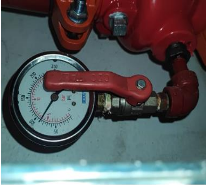
Lectura de manómetros estaciones de control ( cronograma marzo) piso 7 /90 psi
