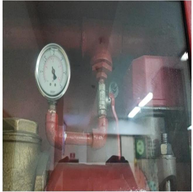
Piso 1 manómetro en daño aproximado 120 psi costado sur se requiere cambio o tener en cuenta en cambio estaciones de control
