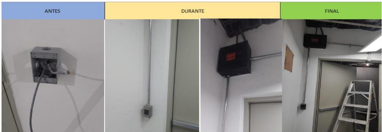
Se realiza el montaje del control de acceso en cuarto de ups sótano el cual se había desmontado durante la obra.
