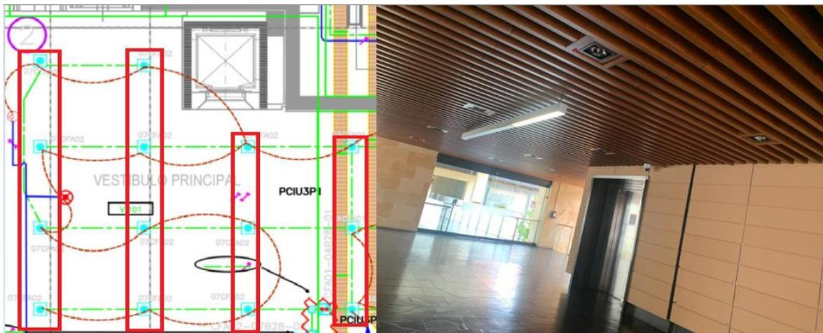
Se recomienda el cambio de reflector AR111 de 110 a 120V dimerizables, de lo contrario se deja el sistema directo sin comunicación con el software QUANTUM, se reemplazarían estos reflectores por unos de la referencia AR111 no dimerizable, Esto para dar una pronta solución a las novedades que presenta el sistema de iluminación
