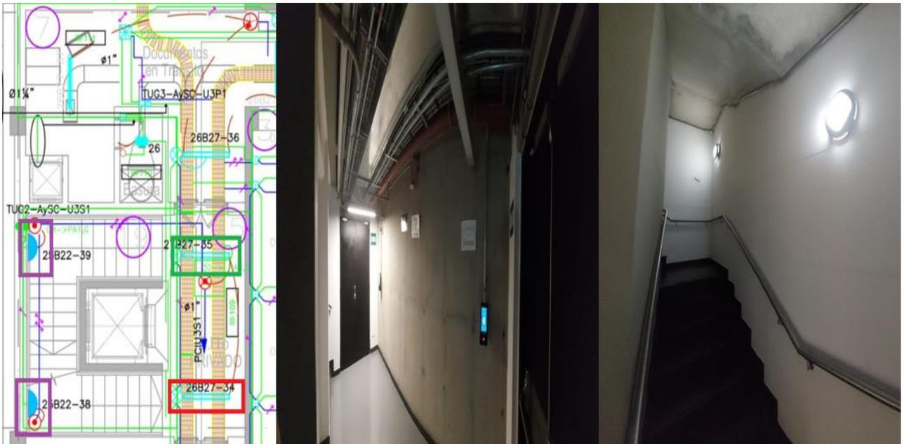
Para brindar solución a la novedad del mes de febrero (iluminación área escaleras) se realiza la siguiente modificación: se instalaron dos rosetas y dos bombillos en conexión directa, lo que afecta la comunicación del sistema QUANTUM con las iluminarias provocando que estén constantemente energizadas, aumentando el consumo de energía para la entidad. Se sugiere la compra del balastro ECOSISTEM EC3DT4MWKU2 de 26 W/32W y bombillos de 32W de 4 pines para que el sistema quede operando adecuadamente.
