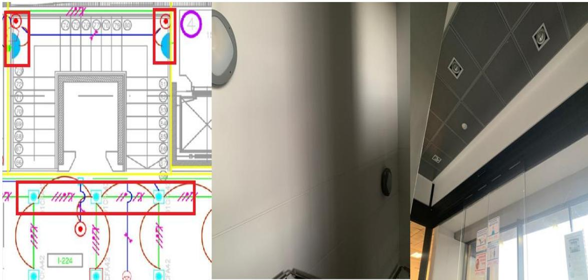
Se sugiere el cambio del balastro y de los bombillos de la referencia ECOSISTEM EC3DT4MWKU2 de 26 W/32W y bombillos de 32W de 4 pines para que se configure con el programa QUANTUM y no tenga ninguna afectación en el sistema. (De lo contrario se recomienda la compra de dos rosetas y dos bombillos para brindar solución pronta, lo que ocasionaría la pérdida de comunicación con el software QUANTUM y el control sobre esta área aumentando el consumo de energía ya que quedaría directa).
