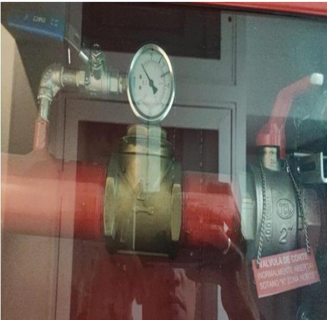
Estaciones de control costado norte sótano presión 0 psi hasta aprobación correctivo splinker comedor para habilitar sistema
