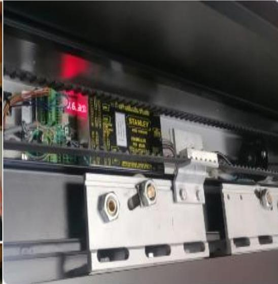
Mtto puerta automática uni 2 piso 1 motor no tiene encoder y esta desconectado de la controladora sensor hacia el parqueadero se encuentra apagado
