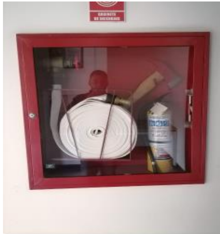
Inspección de elementos de gabinetes RCI pendiente suministro e instalación de 33 martillos de fragmentación y suministro e instalación de vidrio para gabinete tipo 2 # 14
