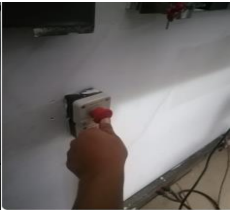
Activación de botón de emergencia para liberación de torniquetes cra 8
