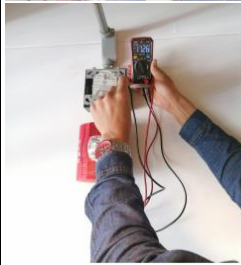
Medición de loop módulos de verificación SB
