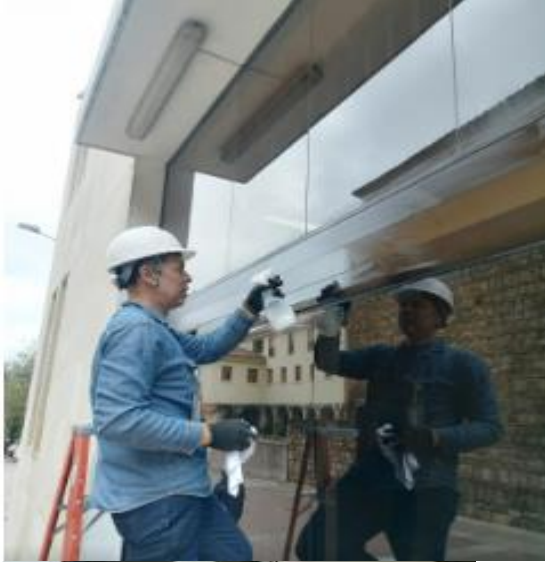
Instalación guía inferior puerta automática CRA 7
