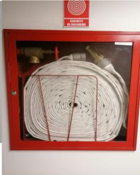
Inspección de elementos de gabinetes RCI
