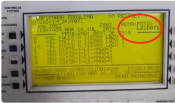
Se reporta por parte de monitoreo Santa Bárbara falla sensor de humo dirección 71
