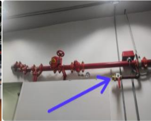
Pendiente instalación de tuberías para drenajes RCI Pendiente la reestructuración de la RCI acordé a en todos los 10 pisos, y columna principal norma en pisos (-1, 4, 5,6) San Agustín
