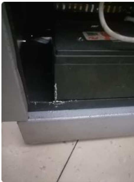
Batería se encuentra con filtracion
