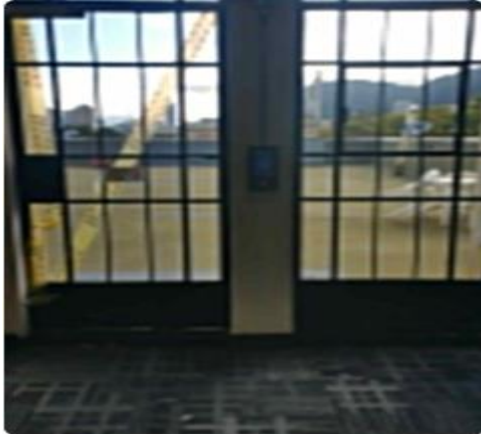
Por solicitud del Sr Samuel Tique se procede a reestablecer las puertas salida terraza piso 7 ambos costados
