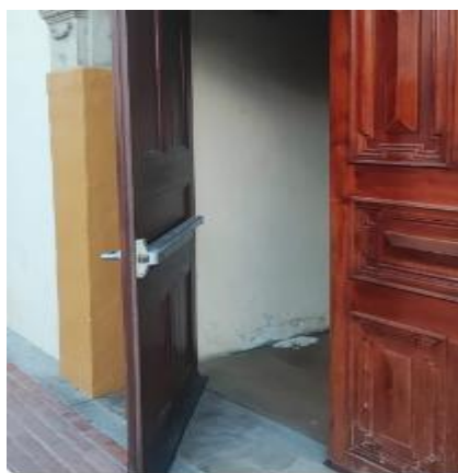
Liberación de puertas de emergencia con sistema de detección
