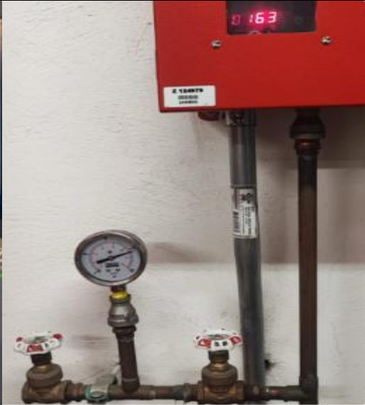
Presión de trabajo automático (presurización bomba jockey)
