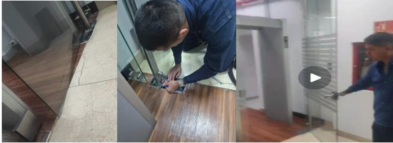
Desmote de control de acceso en data center piso 1 por demolición del techo falso. Se entrega a Orlando en centro de monitoreo piso 5.
