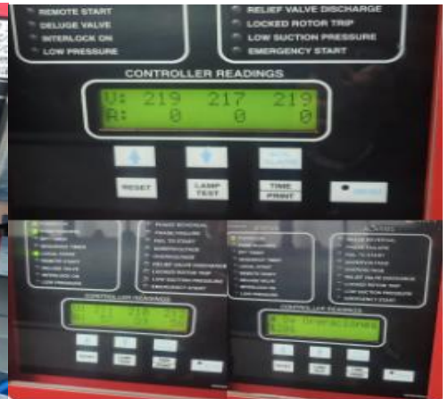
Voltajes y amperajes bomba electrica san Agustín en reposo, en operación y número de horas de funcionamiento
