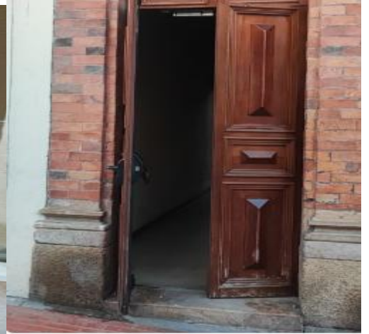
Liberación puerta de emergencia biblioteca
