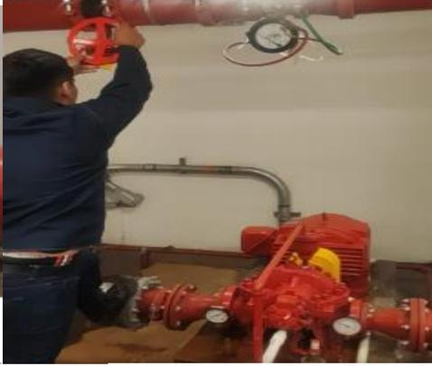
Prueba de funcionamiento bomba eléctrica principal a 150 psi /750 GLP
