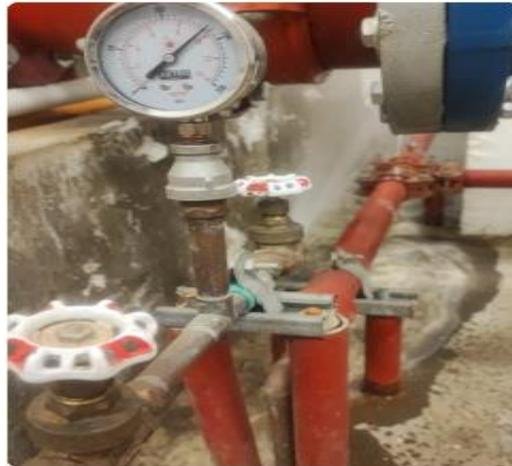
Prueba de funcionamiento con línea de sensado bomba jockey
