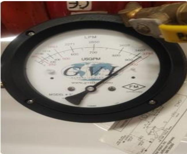
bomba 100% en demanda autonomía de 950 gpm / bomba de 85 HP a 500 gpm / motor de 75 HP con un rendimiento superior de 450 gpm sobre diseño de sistema
