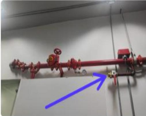
Pendiente instalación de tuberías para drenajes RCI Pendiente la reestructuración de la RCI acordé a en todos los 10 pisos, y columna principal norma en pisos (-1, 4, 5,6) San Agustín
