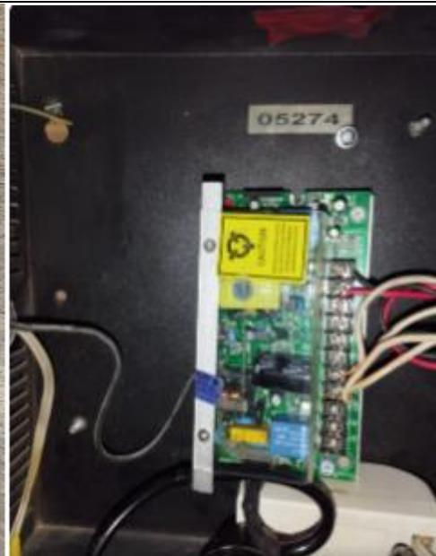
Acceso Cuarto electrico piso 8 se realiza cambio de fuentes de voltaje por daño. Sistema restablecido y funcionando
