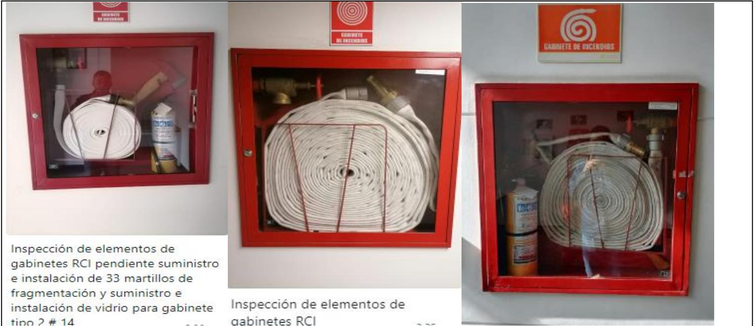
Inspección de elementos de gabinetes RCI pendiente suministro e instalación de 33 martillos de fragmentación y suministro e instalación de vidrio para gabinete tipo 2 # 14
