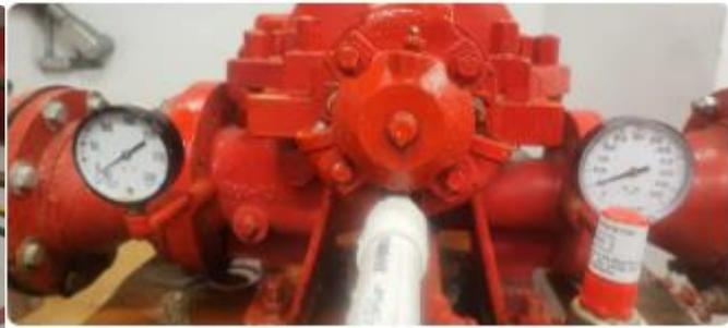
Presión de succión 40 psi / presión de descarga 50 psi
