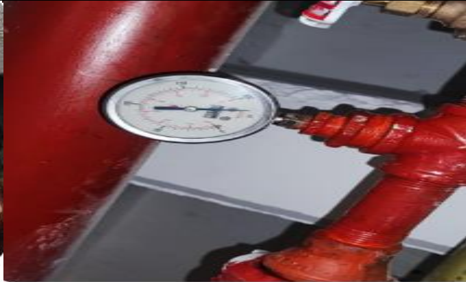
Manómetro U2S1N se requiere cambio
