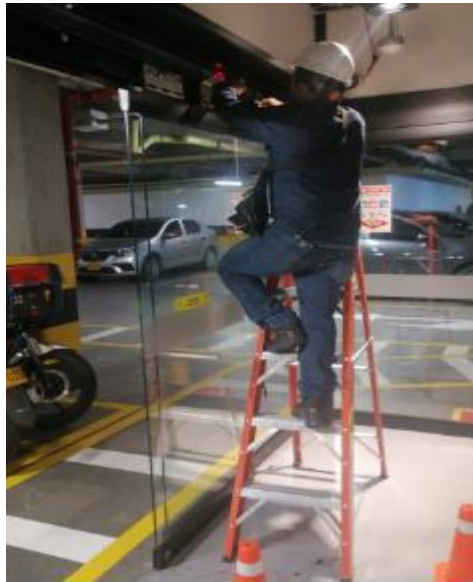
S3 U1 revisión de puerta automática ascensores
