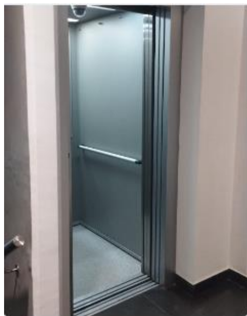
Unidad1 Piso1 ascensor bloqueado
