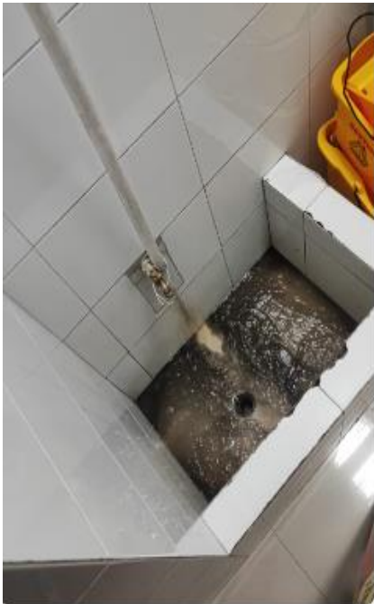
Drenado de RCI. Piso 6 para cambio de sprinkler el día de mañana
