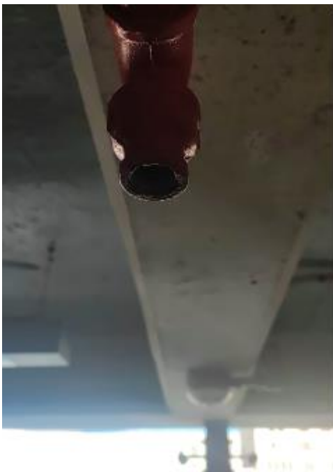
Instalación splinker 1/2 en piso 2 biblioteca
