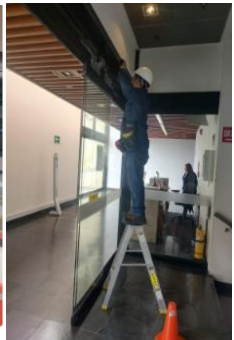
Puerta de carga
