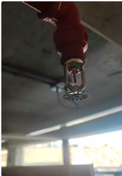
Listo , se procede a presurizar nuevamente la red
