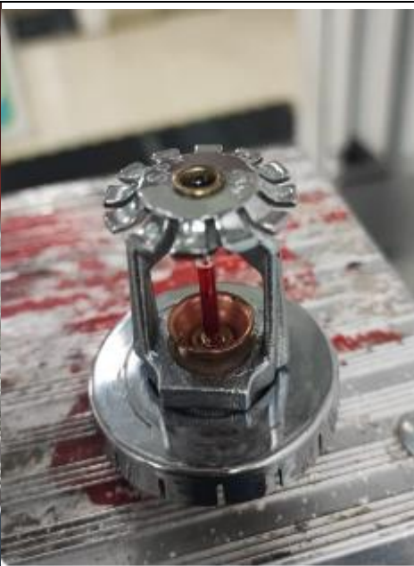
Cambio de sprinkler piso 6 ingreso
