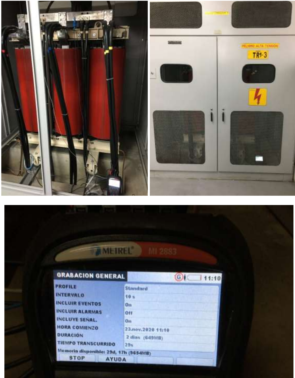
Ilustración 1 Instalación del equipo
