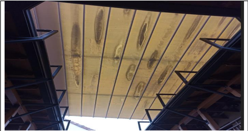
Fotografía 3. Estado actual Cubierta
