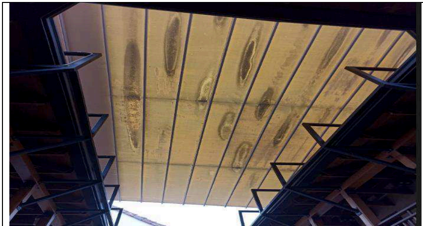
Fotografía 3. Estado actual Cubierta
