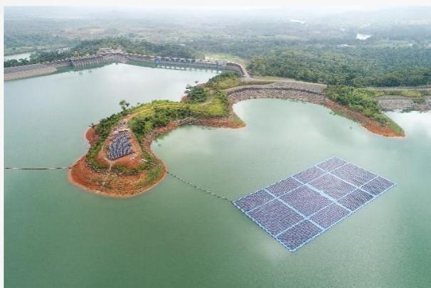
La planta Solar Aquasol construida y operada por la empresa URRÁ está compuesta por dos áreas: una plataforma flotante y una estructura fija sobre tierra, con una potencia instalada de 1,53MWp (plataforma flotante más estructura sobre tierra) y una capacidad efectiva de 1,35MWac. Tiene como propósito suplir en las horas de sol el consumo de energía de los servicios auxiliares de la Central Hidroeléctrica, así como ser usada con fines investigativos.
